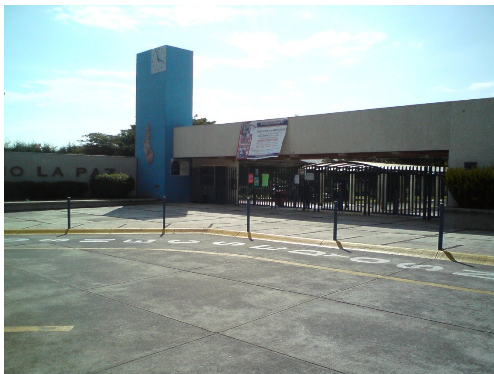
Foto 3.2: Fachada del Colegio La Paz.
