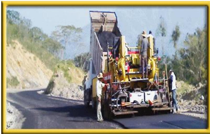
Imagen 1.4.- Máquina finisher para el extendido de la mezcla asfáltica.
