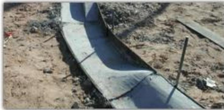
Imagen 1.7.- Bordes y cunetas de un pavimento rígido.
