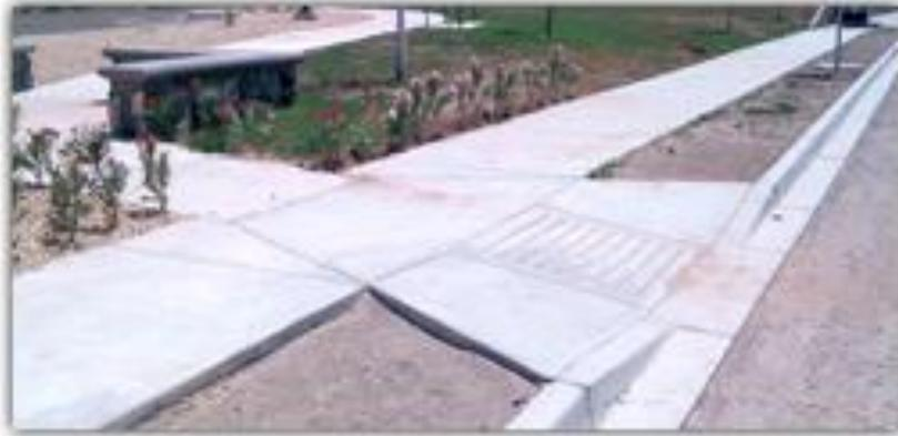
Imagen 1.6.- Bordes y cunetas de un pavimento rígido.
