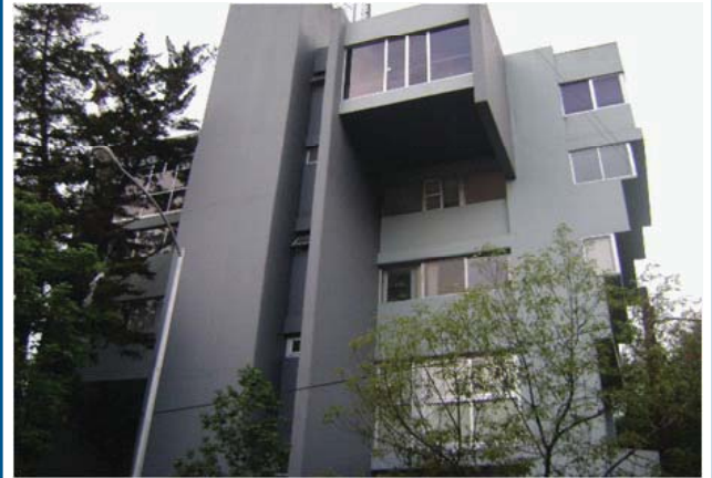
FOTO 10. EDIFICIO DE OFICINAS SOBRE MANUEL M. PONCE.
