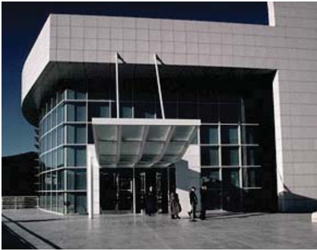
Fig.6 Marquesina mostrando el ingreso al auditorio.
