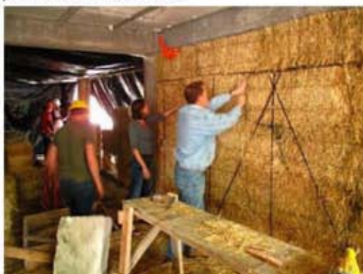
Construcción de muros de pacas de paja. Taller 13 Arquitectura Regenerativa. Proyecto Nicolás San Juan. Primer edificio de departamentos en México que cuenta con muros de paja.
