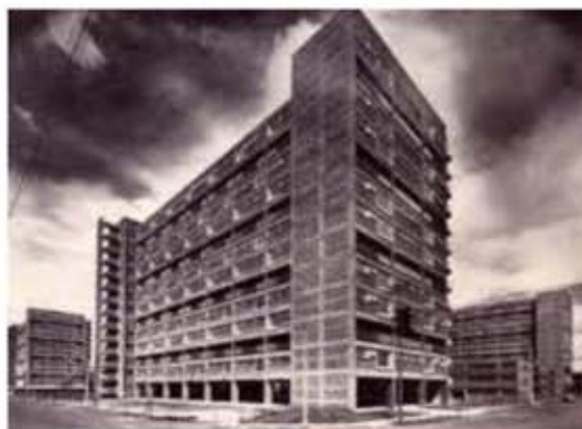
Multifamiliar Miguel Alemán. Finales de los años cuarenta, llevado a cabo por el Arquitecto Mario Pani.
