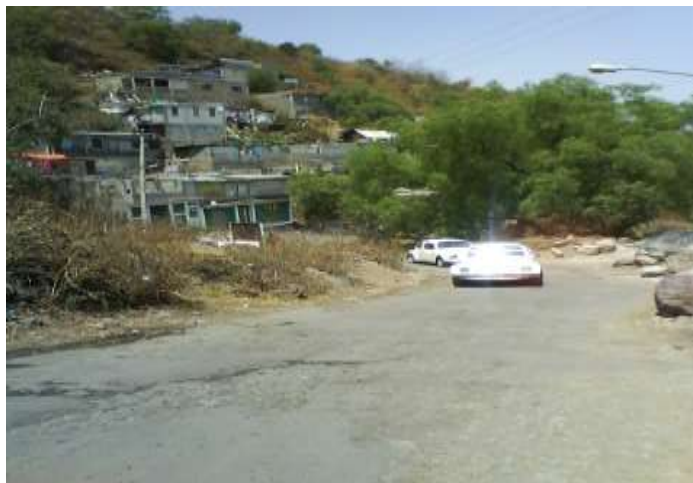
Imagen N.9. Construcciones de la vivienda sobre pendientes.
