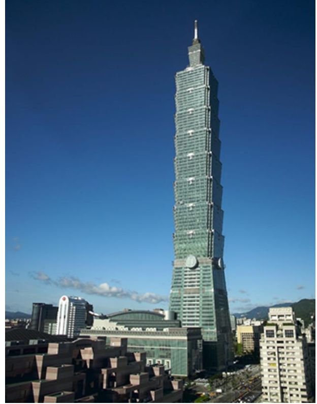
Figura 1.14.- Taipei 101. Taiwan, China Fuente: Marqos arquitectura
