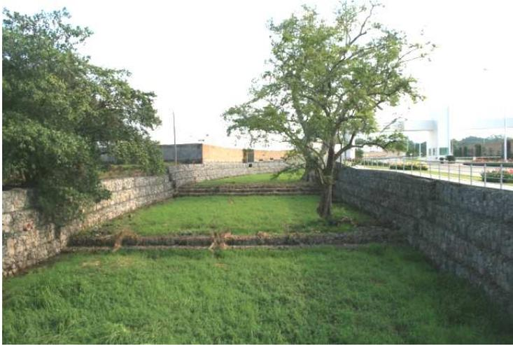
Fig. 73. Fotografía del Río Pereyra en su sección rectificada bajo la técnica de gaviones.
