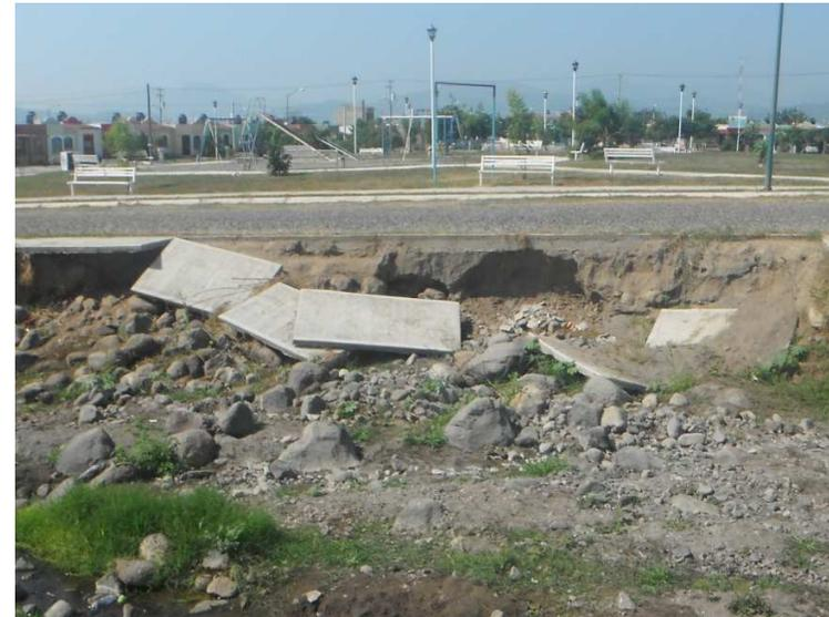
Fig. 48. Destrucción de estructuras y vialidades, procesos erosivos provocados por el aumento del volumen de agua del Arroyo Trejo.
