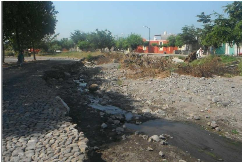
Fig. 49. Destrucción de estructuras y vialidades, procesos erosivos provocados por el aumento del volumen de agua del Arroyo Trejo.
