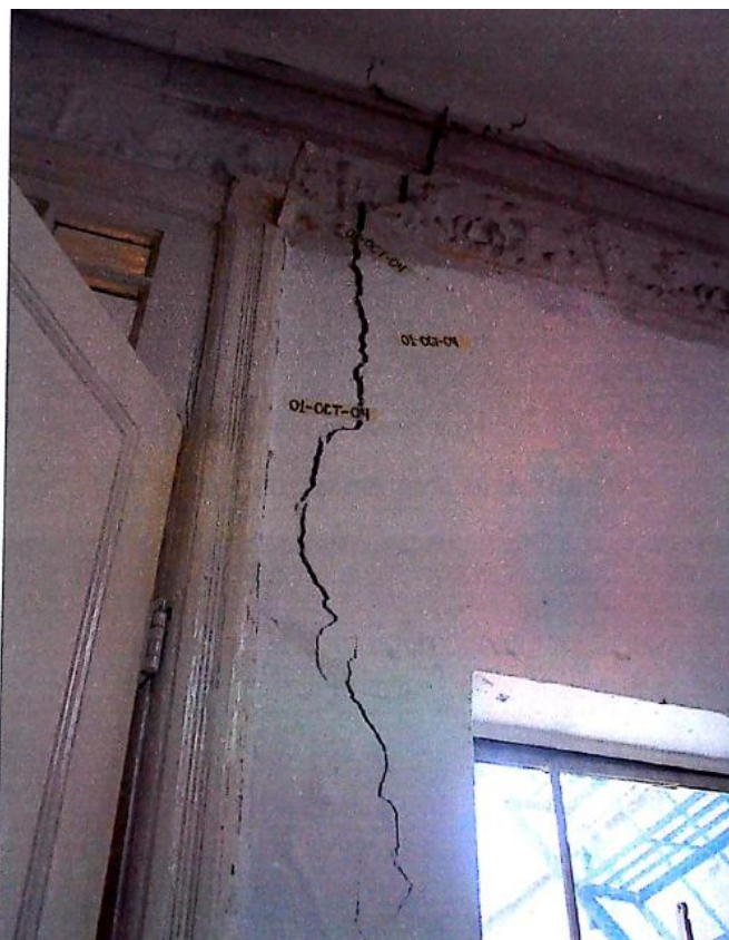
Muro que colinda con el techo en el nivel 3
