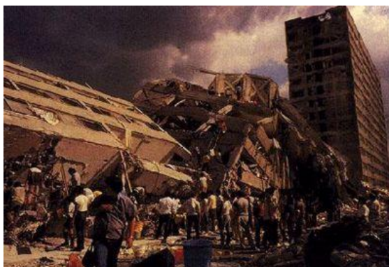
Edificio afectado por el sismo de 1985 en el complejo habitacional de “Tlatelolco” ubicado en la Ciudad de México. 14
