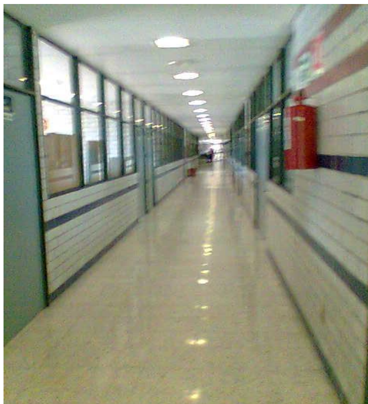
Imagen 14. Área de rehabilitación del Hospital Psiquiátrico Fray Bernardino Álvarez.
