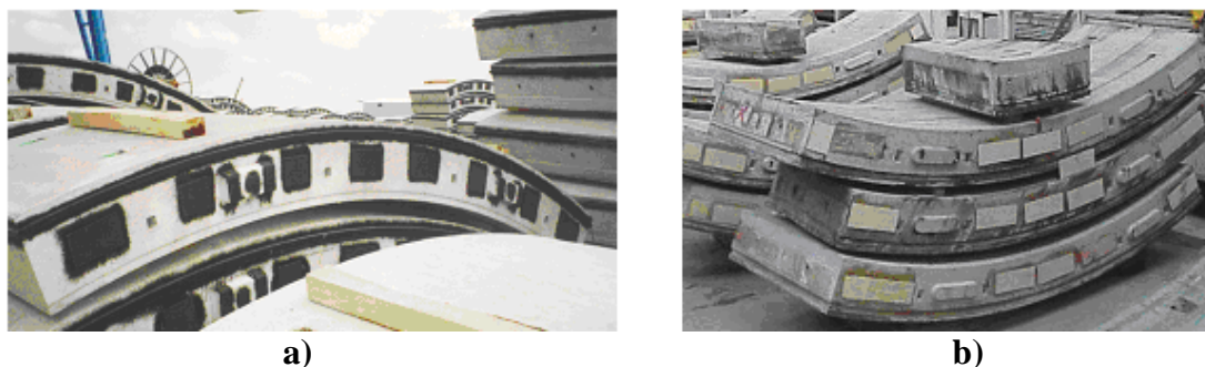
Figura 4. Dodelas prefabricadas, con material de empaque en sus juntas entre anillos Lutikholt (2007): a) plástico (“Kaubit”); b) madera contra chapada (“Plywood”)
