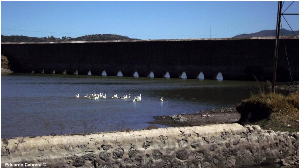
Imagen 3. 2. Arquería correspondiente al tramo analizado
