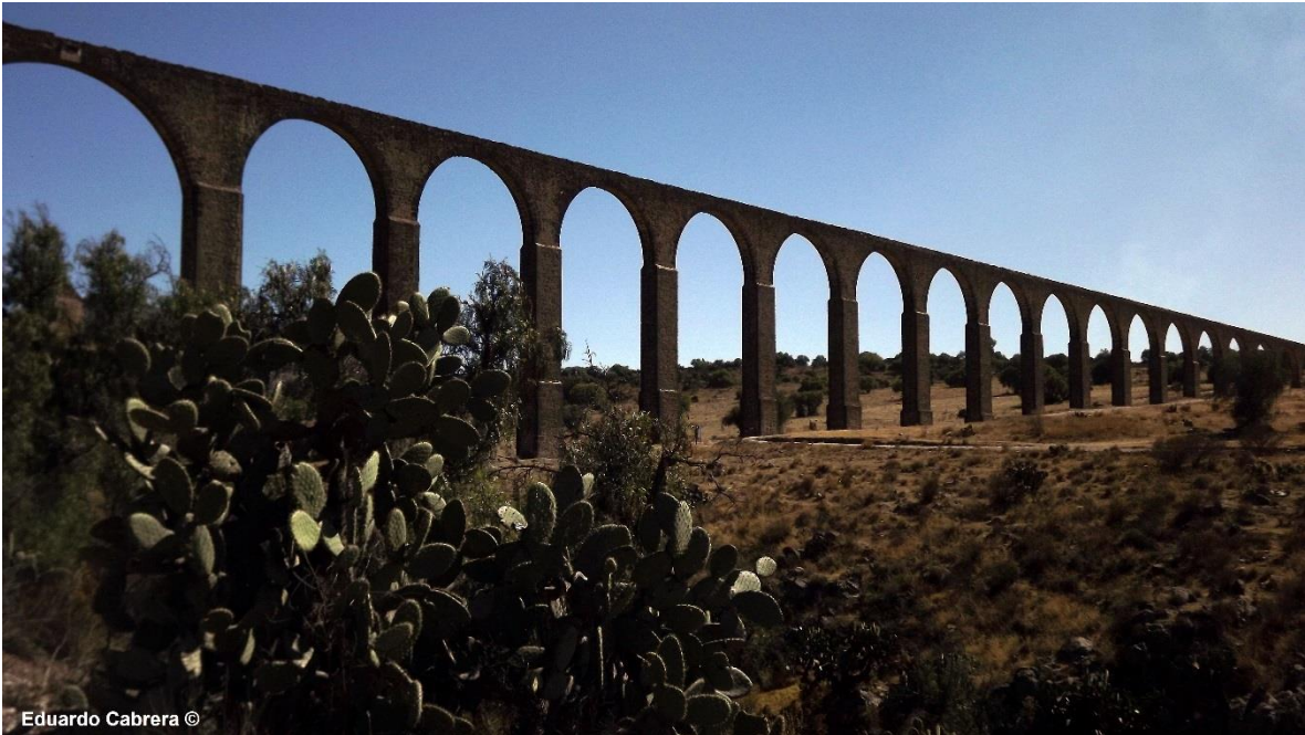
Imagen A. Vista de la Arquería Monumental del Acueducto Tembleque
