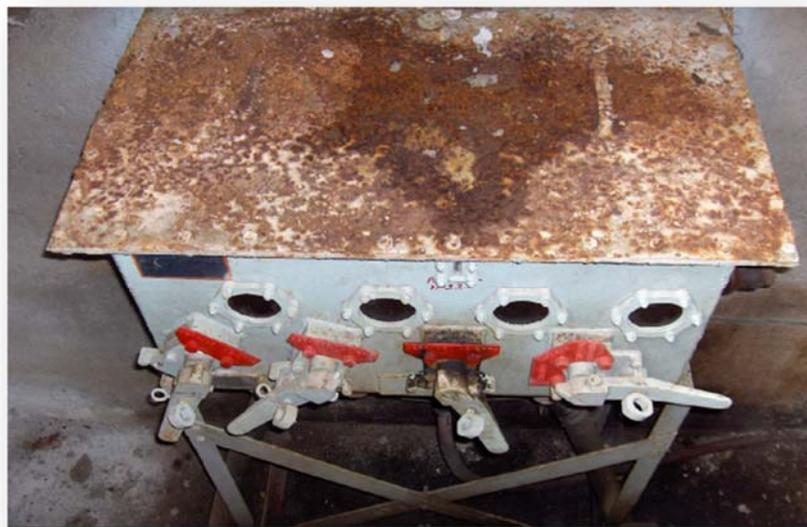
Seccionador trifásico de tres vías con aislamiento en aceite mineral.
