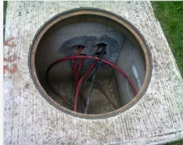
Fig.M.- Vista diagonal del registro de media tensión (Paso Cuadrado).
