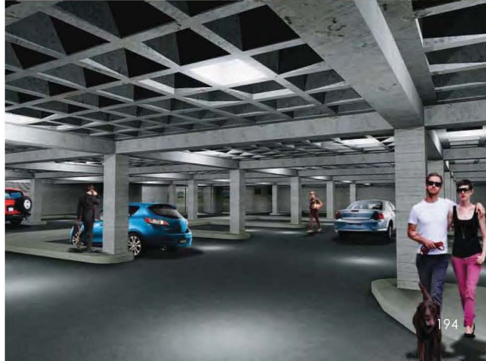
Vista interior a estacionamiento subterráneo//Desde acceso vehicular
