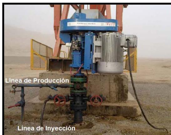
**Imagen 6.32. Equipo superficial del sistema PCP combinado con SAGD.**
