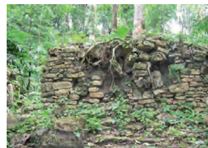
Muro estado actual
