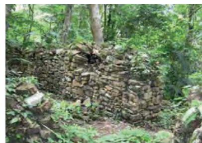
Muro estado actual
