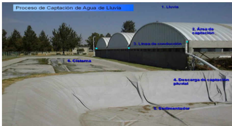
Figura 24. Proceso de captación de agua de lluvia del CIDECALLI. Fuente: Propuesta de plantas de potabilización y purificación de agua de lluvia – REMA ( www.agua.org.mx/index.php )
