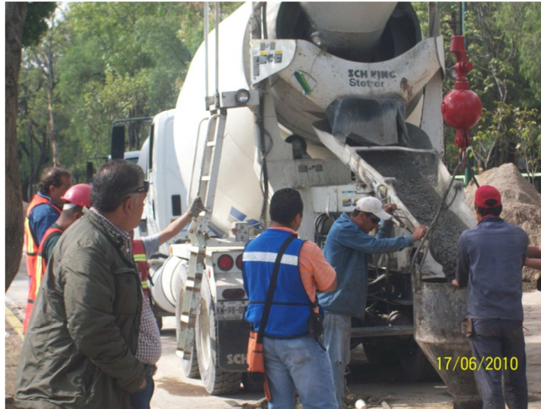
Colado de pila.
