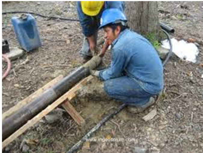
Extracción de muestra de la perforación con equipo neumático.
