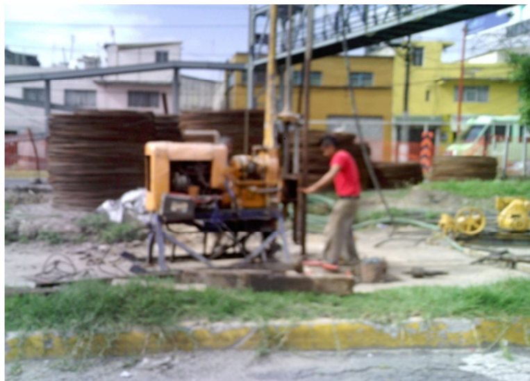
Perforación con equipo neumático SPT-1.
