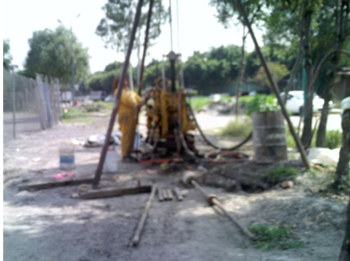
Perforación con equipo neumático SPT-2.
