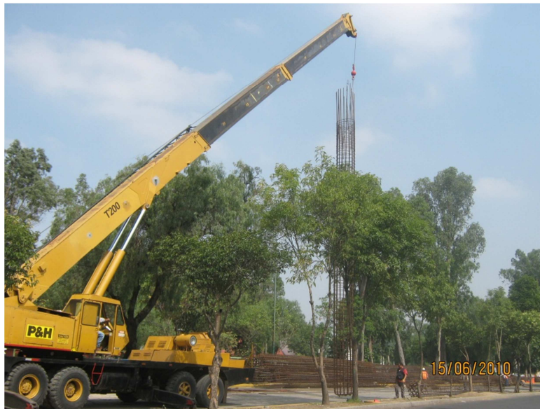
Cimbrado de acero en pila de cimentación para colar.
