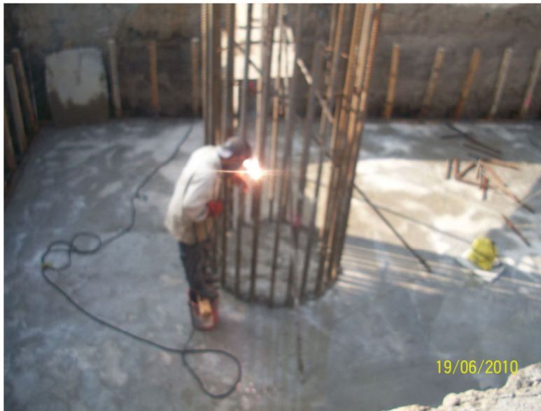
Colocación de bulbos de acero de refuerzo en columnas.
