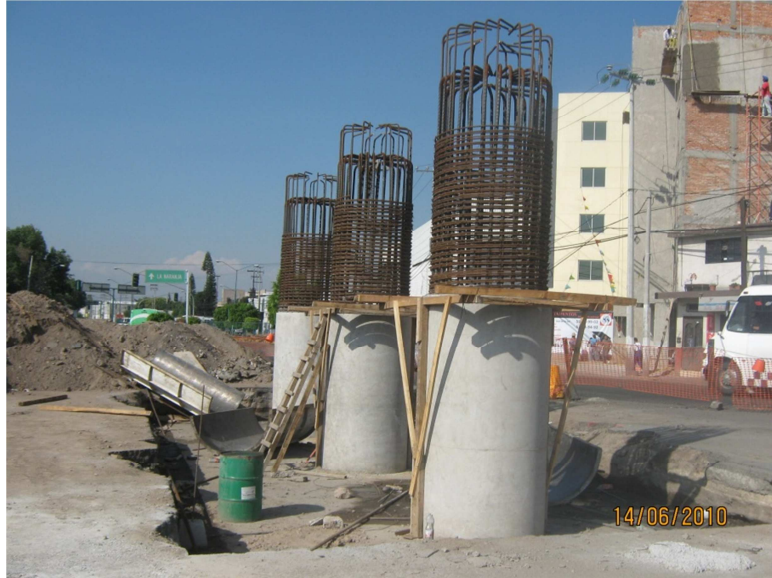
Colado de columnas.
