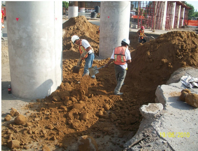
Relleno con material tepetate sobre zapata.
