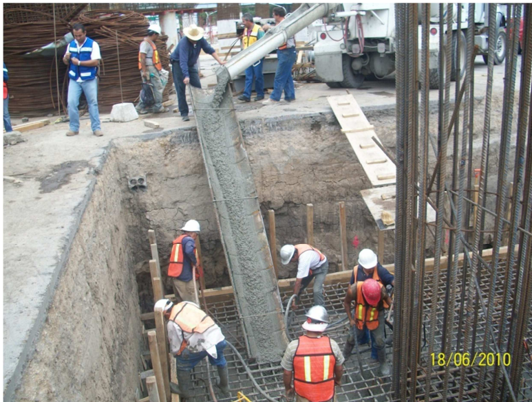
Colado de zapata.
