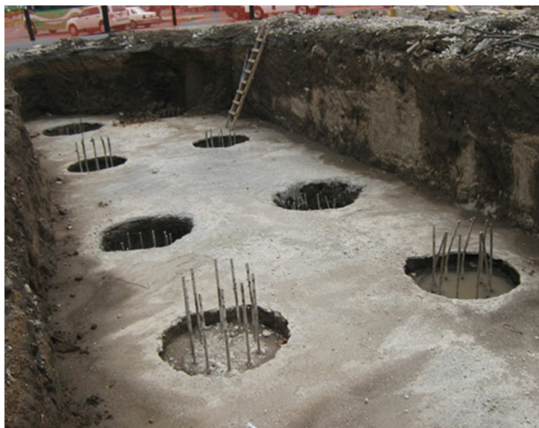
Plantilla de concreto sobre pilas coladas.
