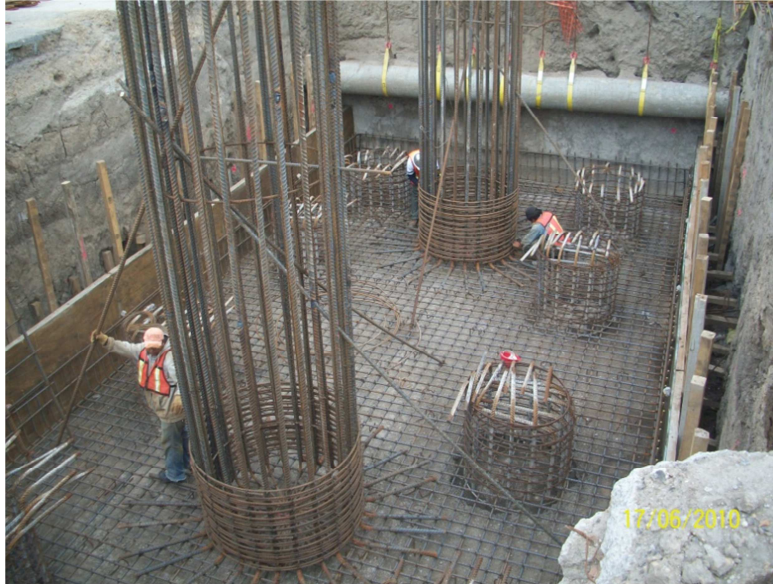
Colocación de acero de refuerzo en zapata y columnas.
