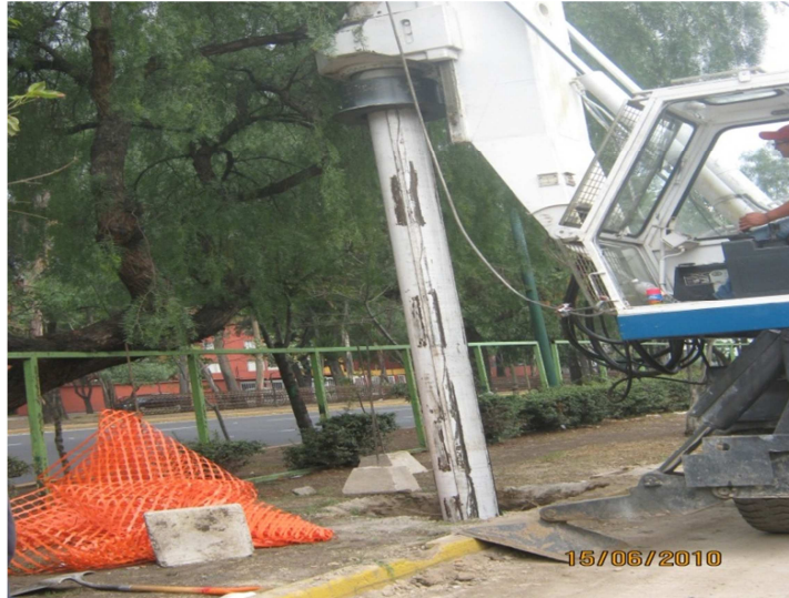
Perforación de pila.
