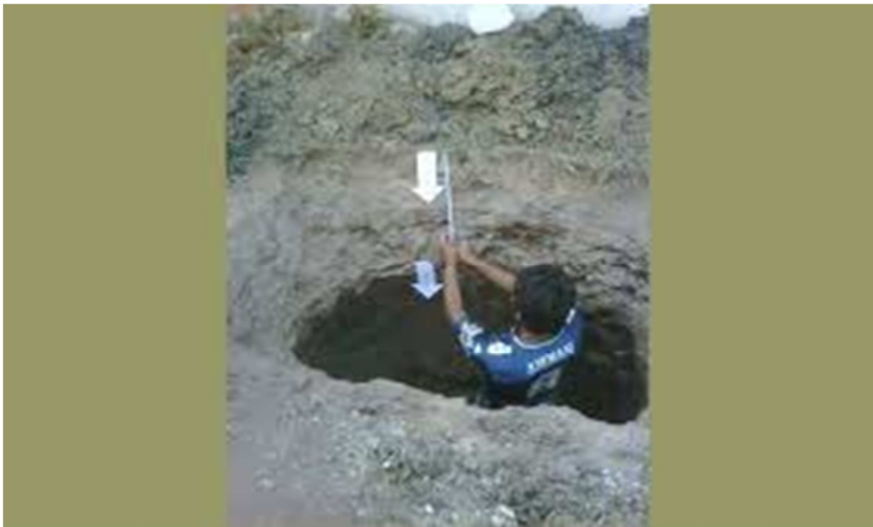
Excavación para extracción de muestra de suelo.
