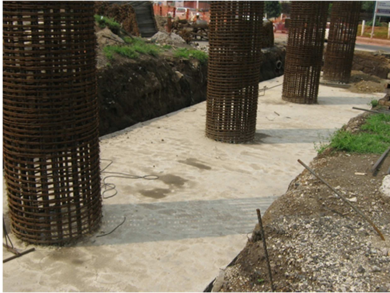
Zapata colada y descimbrada.
