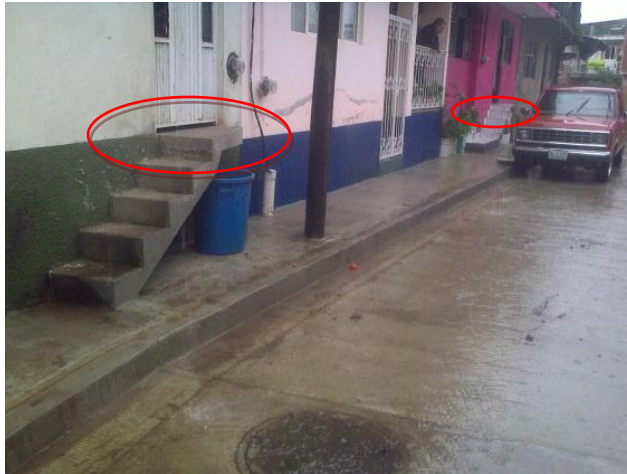
Fotografía. 4.17. Elevación de escalones en casas asentadas sobre el canal, Upn. Mich. (Fuente: Propia)
