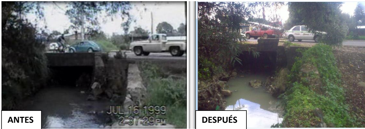
Fotografía. 4.42. y 4.43. Puente Calzada La Fuente, estación 0+000.
