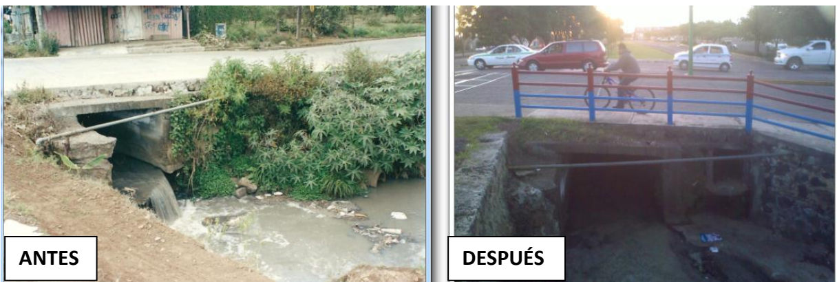
Fotografía. 4.5 y 4.6. Calle Pinzón vista lateral alcantarilla, Upn. Mich.
