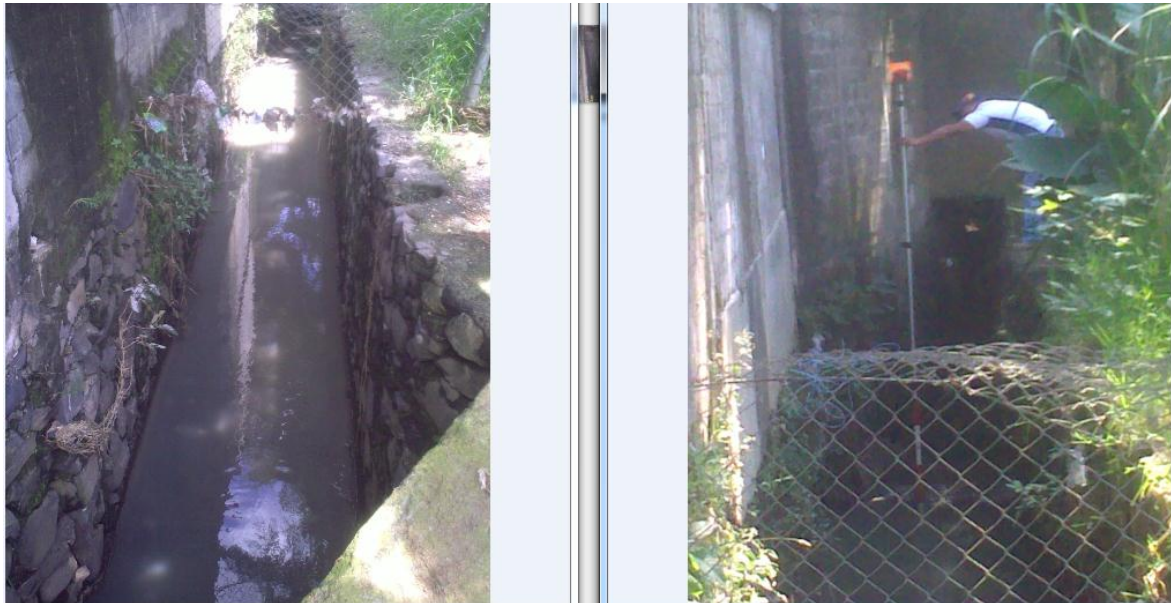
Fotografía 4.28. y 4.29. Canal Arroyo del Páramo, estación 0+280. (Fuente: Propia)
