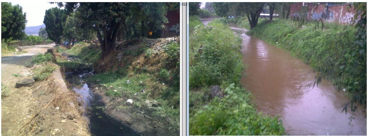
Fotografía. 4.38. y 4.39. Sección casi trapezoidal, estación 0+140.
