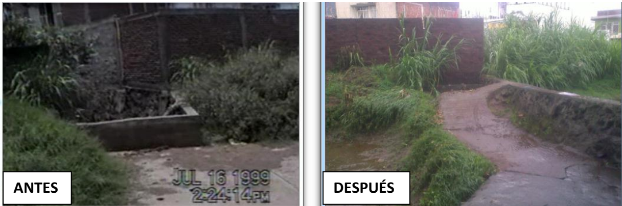
Fotografía. 4.20. y 4.21. Calle Bolivia, estación 0+680. (Fuente: Propia)
