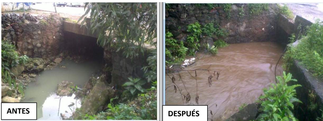
Fotografía. 4.44. y 4.45. Estación 0+000, en estiaje y bajando el nivel pluvial.
