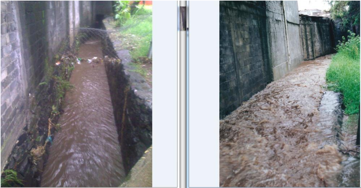
Fotografía. 4.30. y 4.31. Tirante del canal Arroyo del Páramo, estación 0+280.
