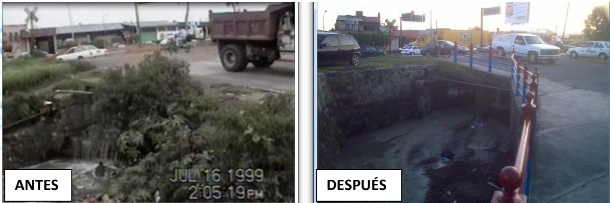
Fotografía. 4.7. y 4.8. Cruce calle Pinzón y Blvd. Industrial. Upn. Mich.
