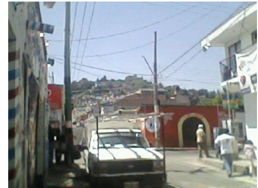
Cruce de calle Reforma y 5 de Mayo con muchos cables en los postes.
