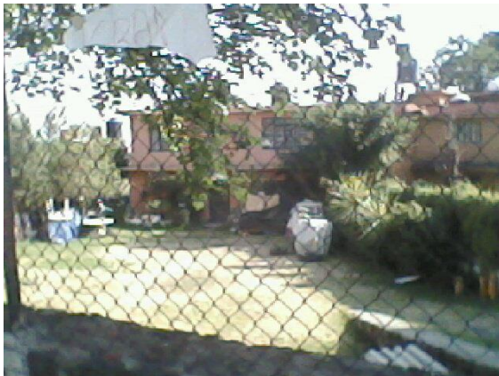
En ésta imagen se muestra una vivienda con 90m2 de construcción por planta, en buen estado
