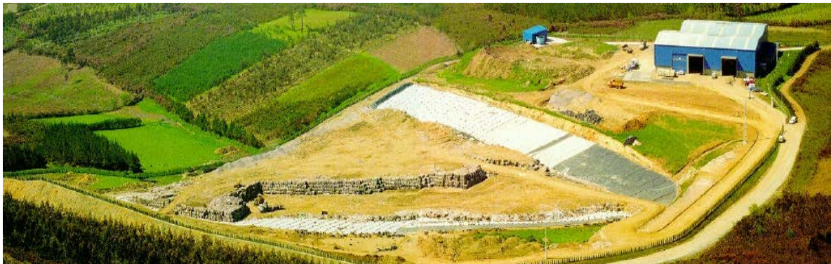
Fig. 2.2. Acomodo de las pacas dentro del sitio de disposición final. Pacas impermeabilizadas (propiedad de ECOFENIX SA de CV) y no impermeabilizadas (propiedad Imabe Iberica SA de CV)
