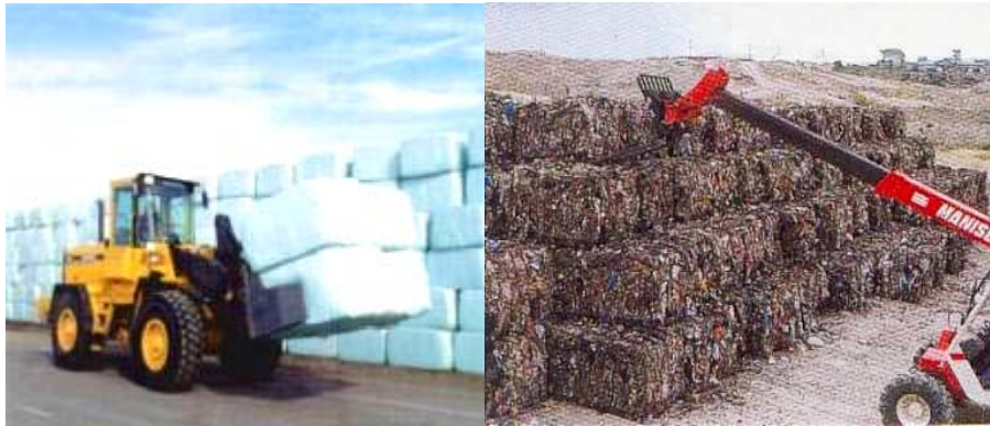
Fig. 2.2. Acomodo de las pacas dentro del sitio de disposición final. Pacas impermeabilizadas (propiedad de ECOFENIX SA de CV) y no impermeabilizadas (propiedad Imabe Iberica SA de CV)
