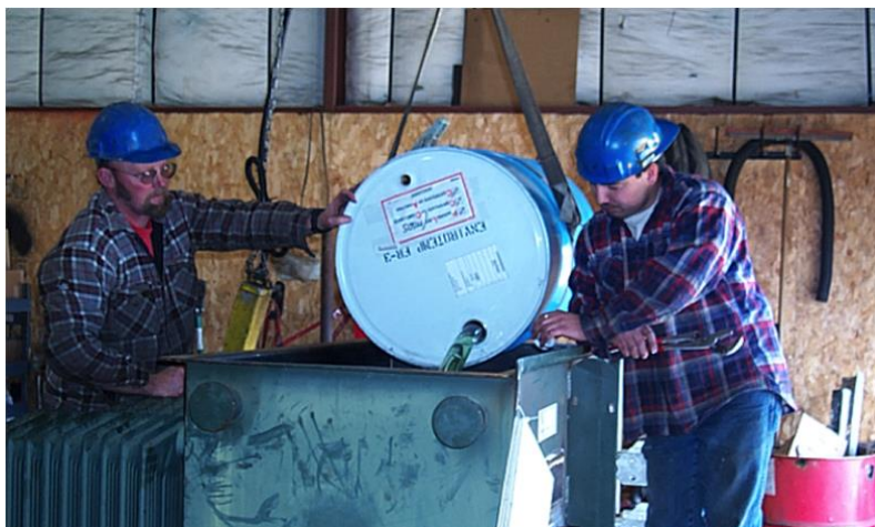
Figura 2-15. Transformadores con baño en aceite.
