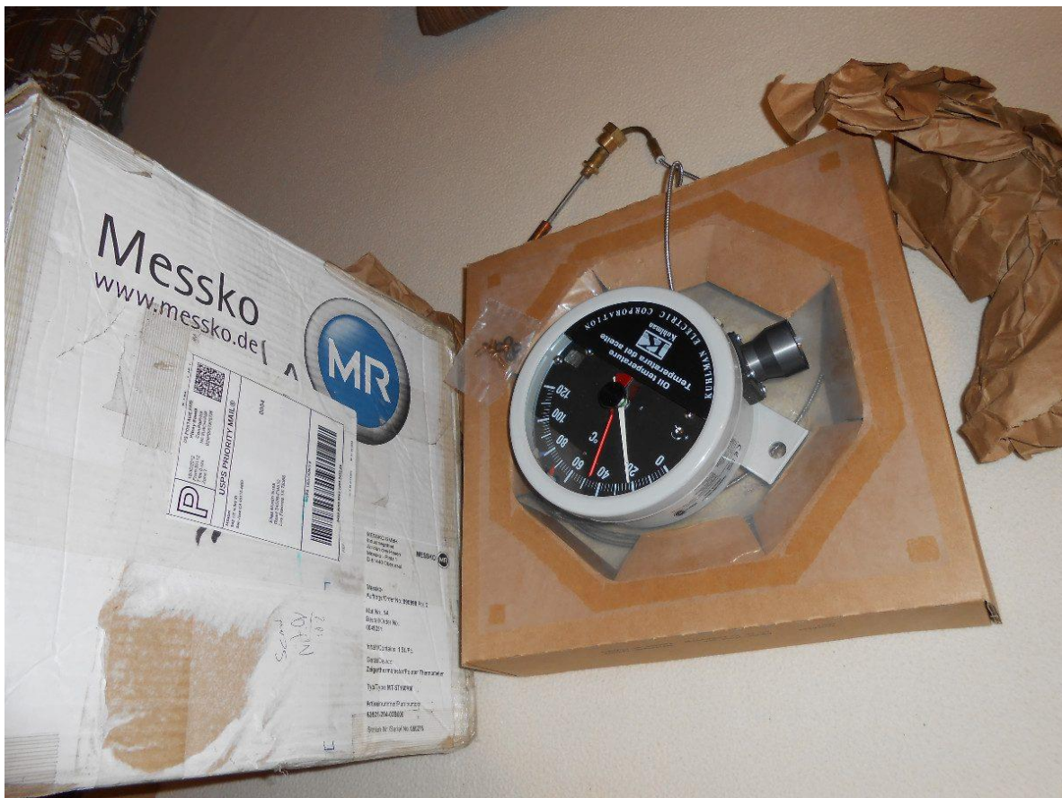
Figura 4-4. Reemplazo de medidor de temperatura de un transformador eléctrico.
