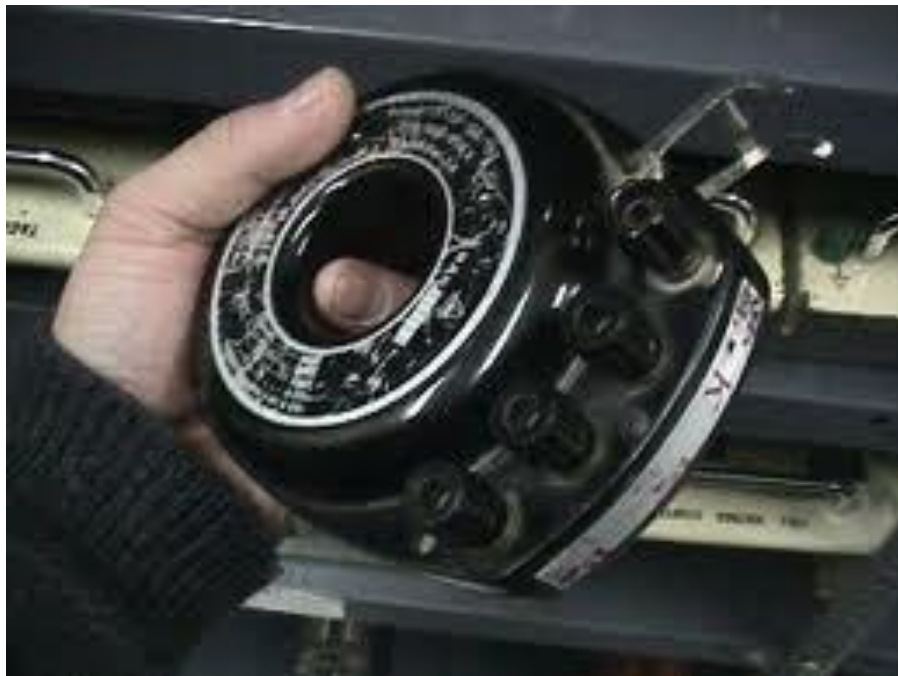
Figura 2-26. Transformador de corriente TT/CC.
