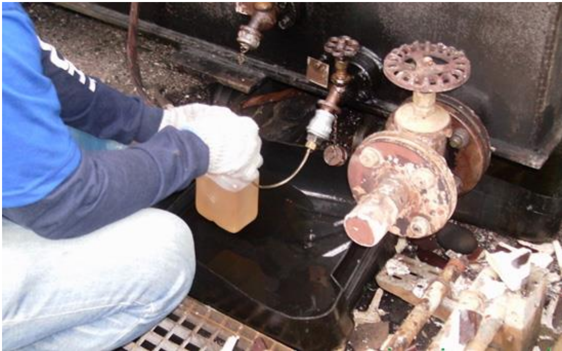
Figura 4-1. Inspección de las condiciones del aceite de un transformador.
