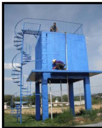
Tanque de almacenamiento
