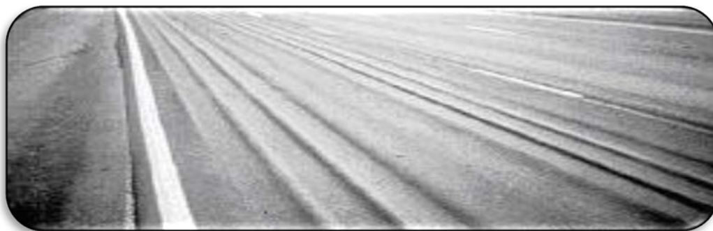
Fig. 4.1.3.1 Formación de roderas en la superficie de rodamiento
