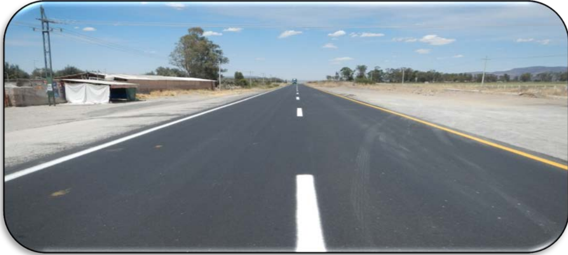
Proyecto de Reencarpetamiento en Carretera Libre Lagos de Moreno - Ojuelos, Tramo del Km. 143+000 al Km. 130+00 en Jalisco.
