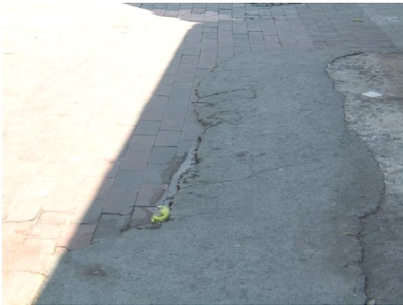
IMAGEN 56. PARCHES EN EL PERÍMETRO PEATONAL EXTERIOR DE LA GI. FOTO: LUZ SÁNCHEZ, 2012
