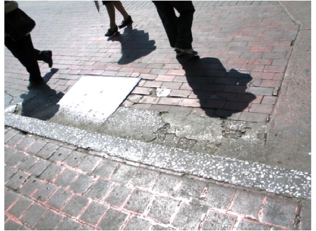
IMAGEN 57. PARCHES Y DEFORMACIONES EN LA SUPERFICIE DE LA PLAZA DE LA GI. FOTO: LUZ SÁNCHEZ, 2012.
