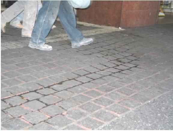
IMAGEN 55. HUNDIMIENTO EL PERÍMETRO DE LA PLAZA DE LA GI. FOTO: LUZ SÁNCHEZ, 2012
