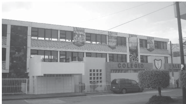
▼ Fotografía de la fachada del Colegio Fray Juan de San Miguel en Uruapan, Michoacán.
