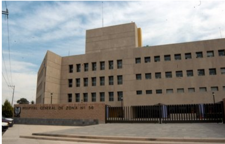
Imagen 6 Hospital General. Fuente: Google Maps.
