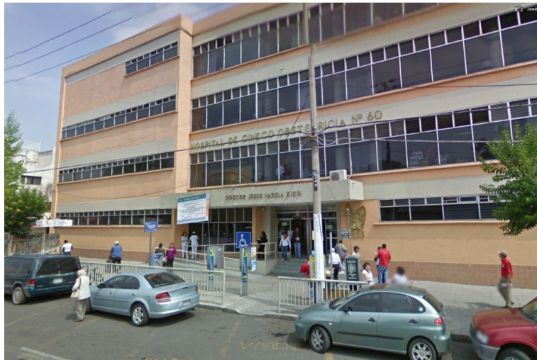
Imagen 7 Hospital de Especialidades. Fuente: Google Maps.
