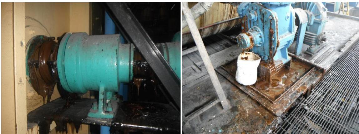
Figura 4.38 Fugas y derrames en el departamento de cristalización y centrifugación.
