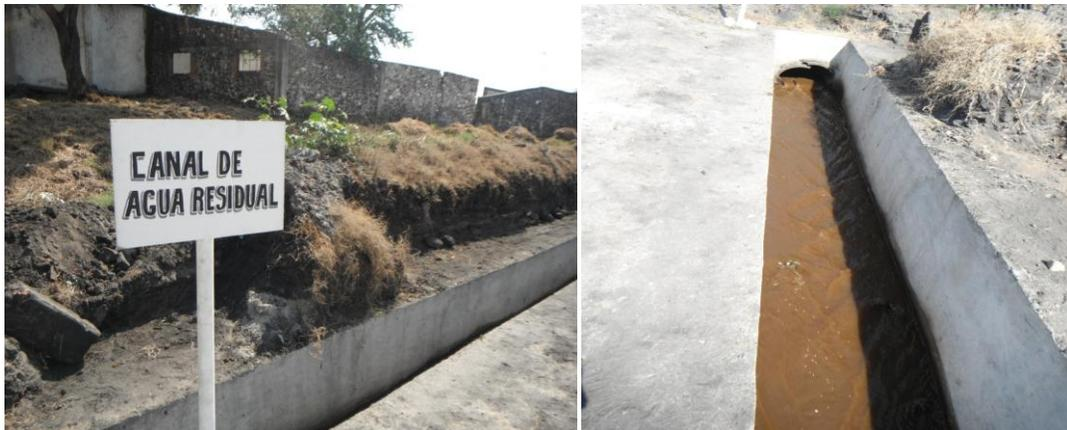
Figura 4.44 Canal de agua residual del proceso de producción de azúcar.
