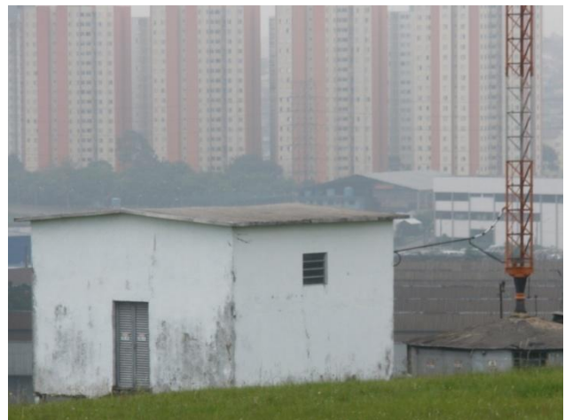
Figura 3.8. Base de la torre y casa de sintonía.
