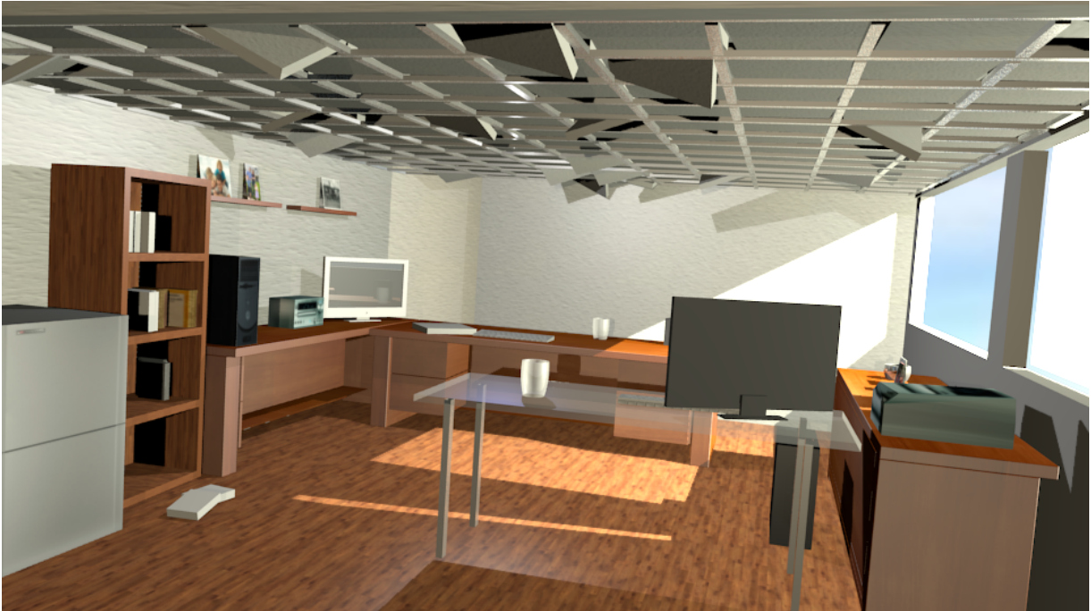
Figura 23. Consecuencias del sismo del 13 de Abril de 2007.
