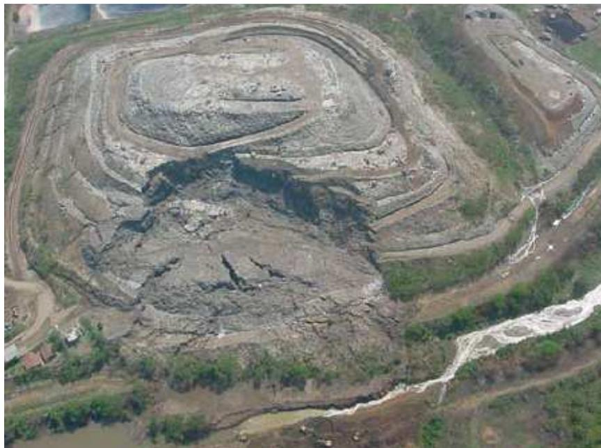
**Figura 3.10 Deslizamiento del Tiradero de Navarro – Cali, 2001 (Espinace, 2003)**
