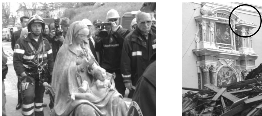
Figura VII Escultura "Virgen con el niño" (izquierda), Basilica de Collemaggio mostrando la falta de una escultura debido a su caída (derecha)
