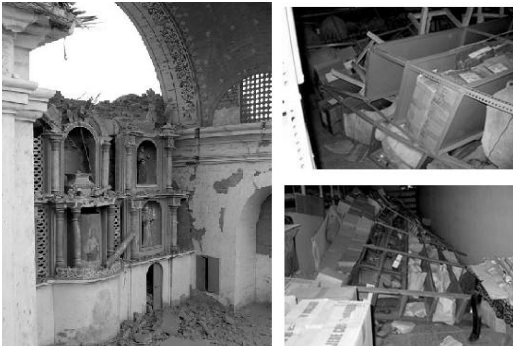
Figura IX Daños estructurales y en contenidos de los recintos culturales en Perú despues del sismo de 2007
