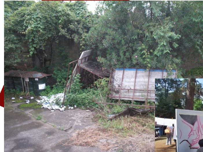
ANTIGUAS RAMPAS DE DEPORTES EXTREMOS, ABANDONADAS EN EL BALNEARIO "CHOLINDE"
