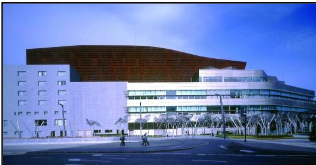
FIGURA 30: Vista del Palacio de Congreso
