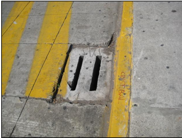
FIGURA 44: Foto tomada por el autor, vista del drenaje
