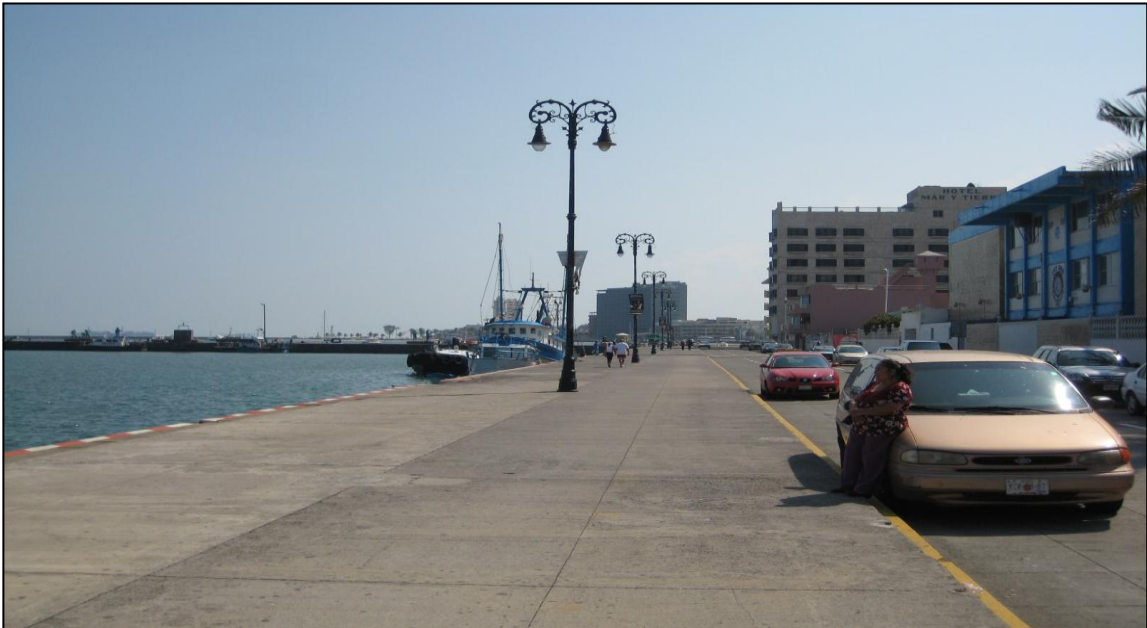
FIGURA 55: Vista del paseo peatonal del malecón
