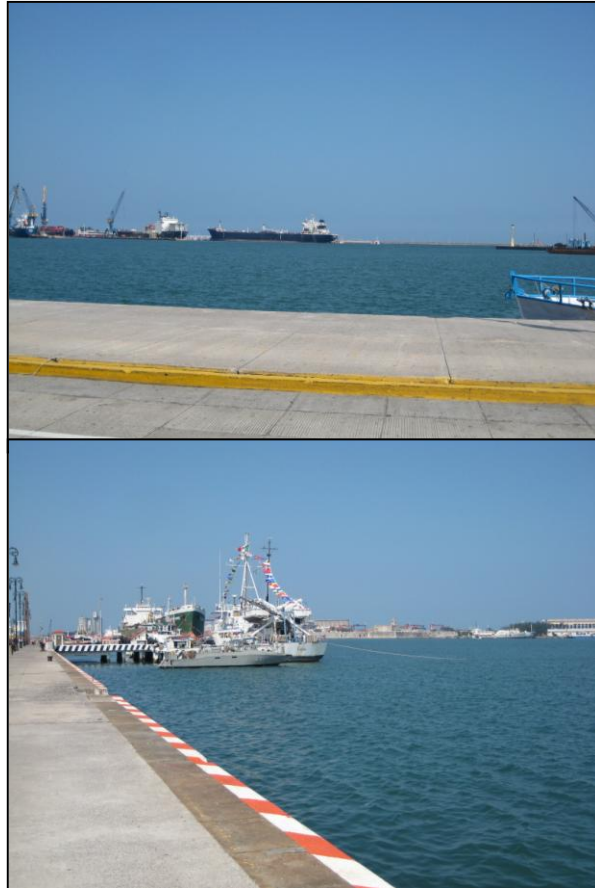
FIGURA 54: Vistas hacia el recinto portuario
