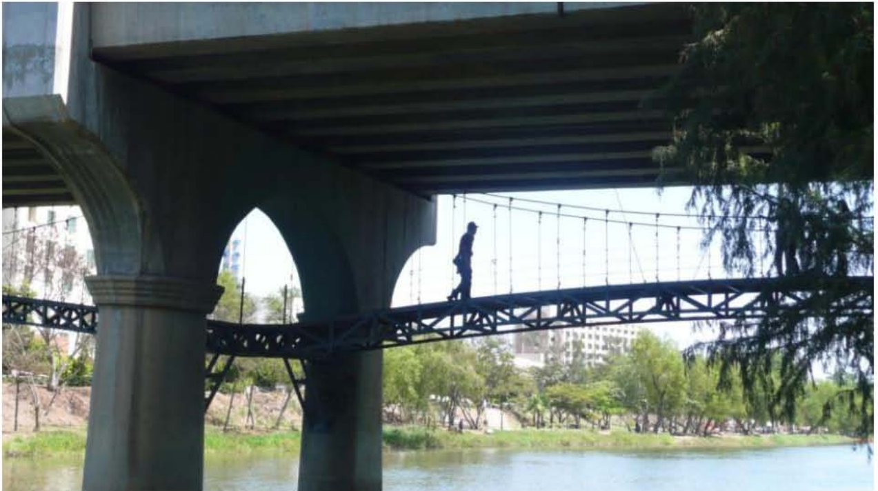
Figura 74: PUENTE PEATONAL DEBAJO DEL PUENTE VEHICULAR DE LA CALLE TEÓFILO NORIS
