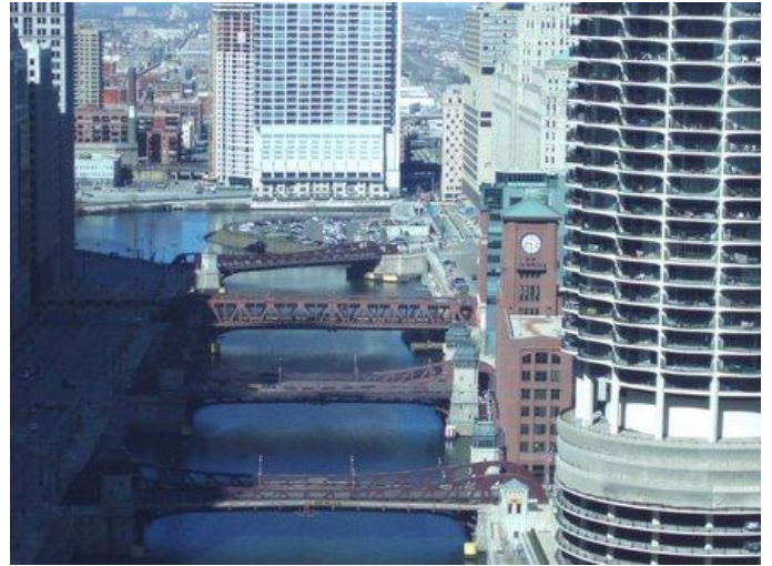
Figura 8. VISTA DEL RÍO CHICAGO
