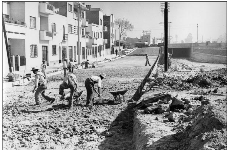
Figura 11. PAVIMENTACIÓN DE LA LATERAL DEL VIADUCTO, A SU PASO POR LA COLONIA ALGARÍN
