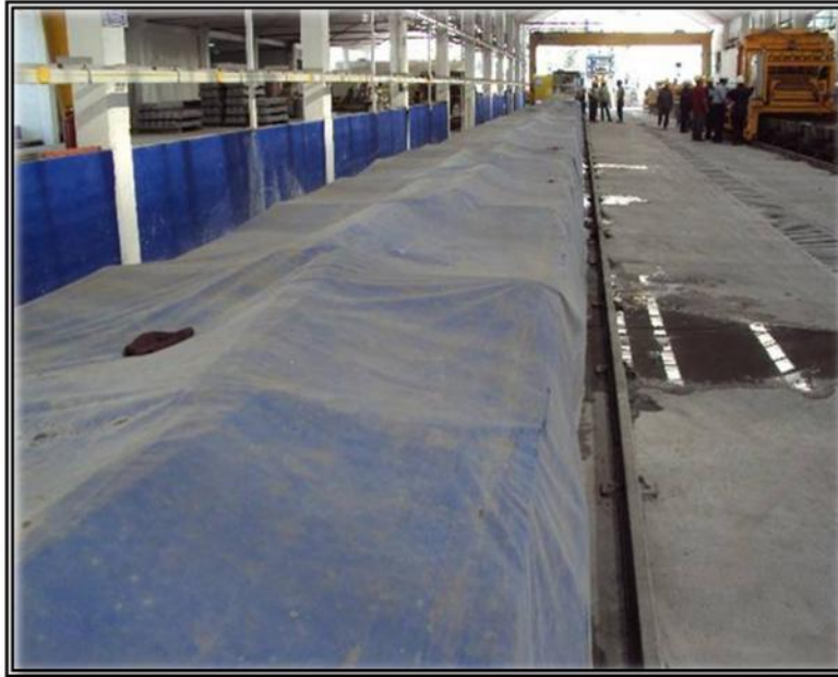
Figura N° 16. Curado a Vapor.
