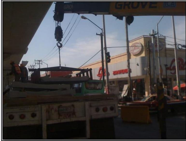
Figura N° 25. Montaje de durmientes por medio de grúa.
