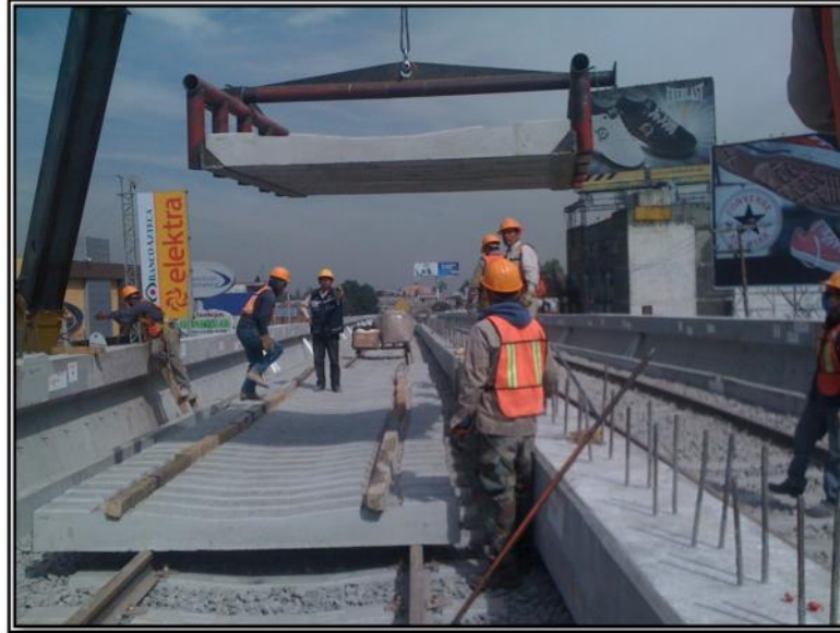
Figura N° 25. Colocación de durmientes.
