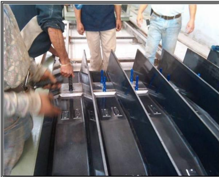
Figura N° 10. Aplicación de grasa en placas y pernos.
