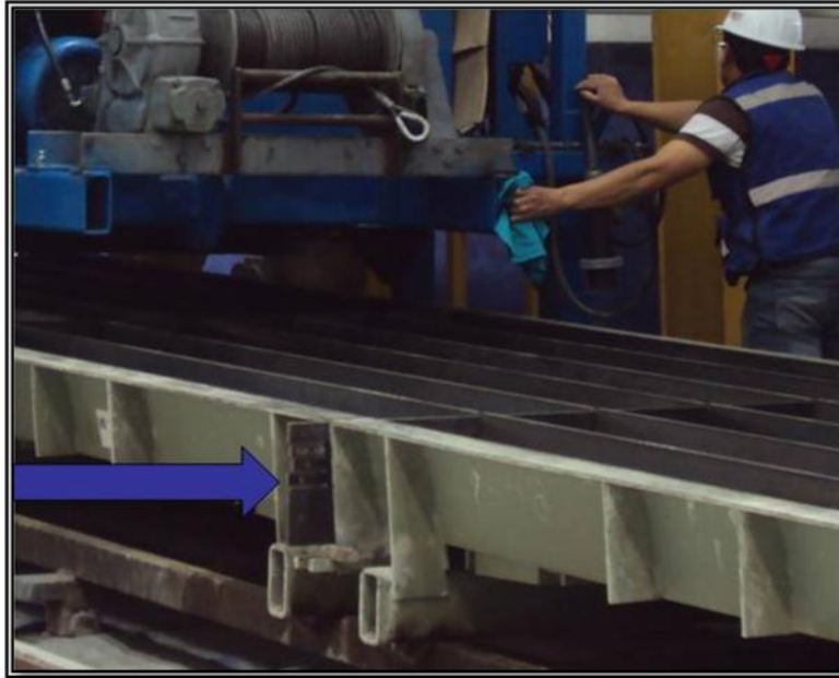
Figura N° 11. Colocación de placas guía.
