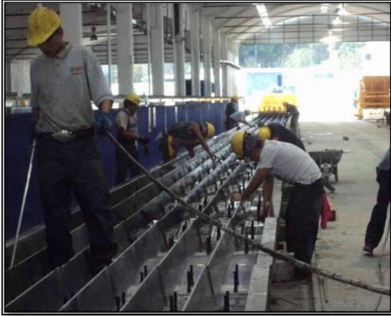
Figura N° 8. Aplicación de desmoldante.
