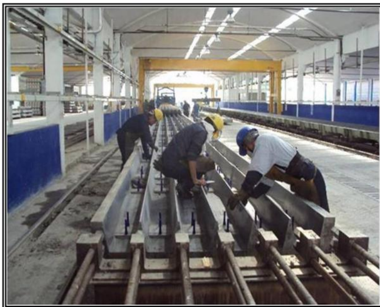
Figura N° 7. Limpieza del molde metálico.
