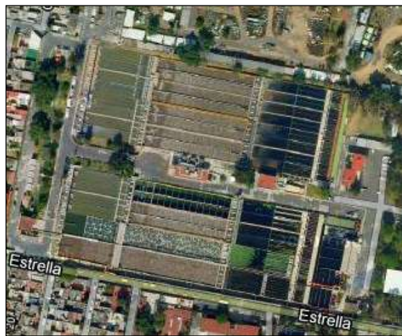
Figura 5.1. Vista aérea de la Planta de Tratamiento de Aguas Residuales Cerro de la Estrella.
