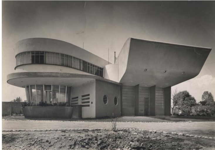
Imágen 7. El Barco, Coyoacán México D.F. Ing. Arq. José Luis Hernández Mendoza, 1950. Aplicada una tecnología en concreto armado logró un volado en cantiliver de 9.90 mts.
