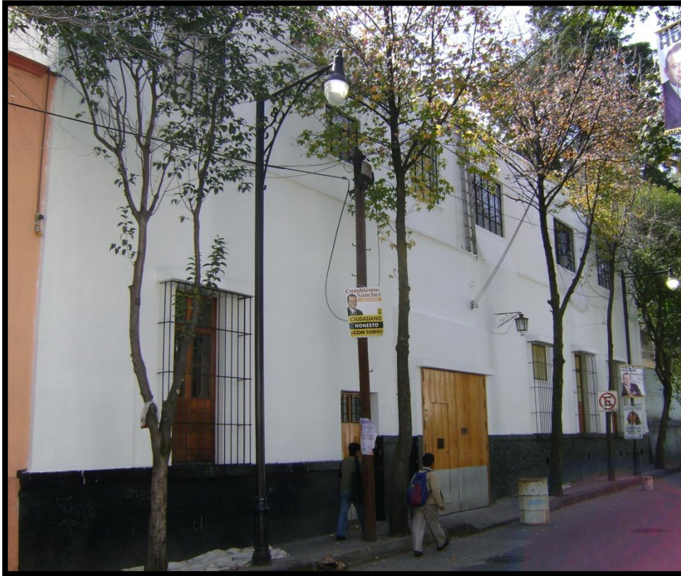
Imagen 48.-Fachada principal sobre la calle de Hidalgo, refleja pérdida de línea, de ritmo.
