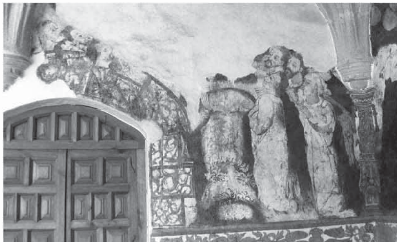
Fig. 110 La ascensión en el claustro alto de Malinalco
