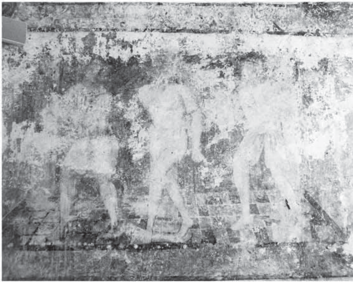
Fig. 42 Jesús atado a la columna en el claustro alto de Tezontepec
