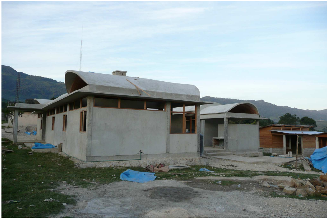
6. Vista suroeste con la boveda concluida asi como los dormitorios (al fondo a la derecha de la foto). Tambien se puede observar el trabajo de repellado en el edificio principal.
