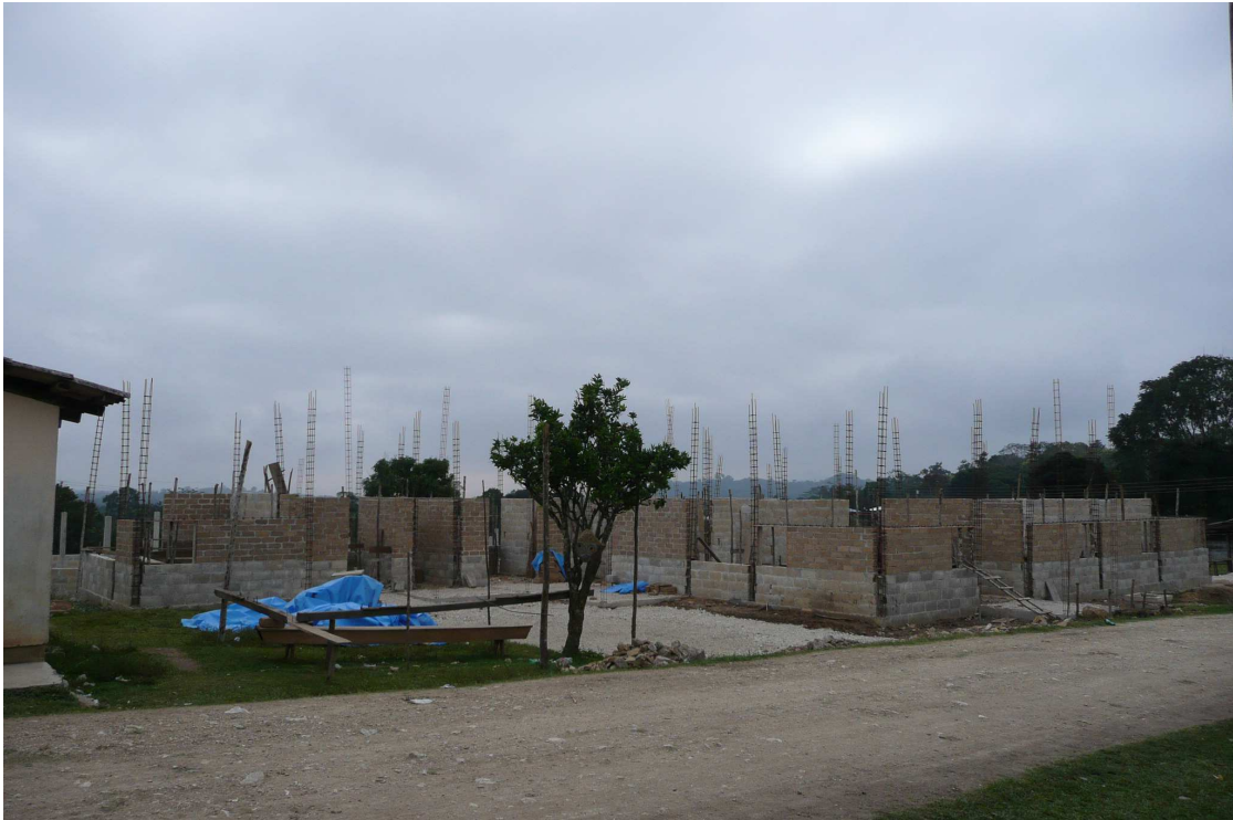
4. Vista noroeste del conjunto. Se concluyo el pegado del B.T.C. y con ello el trabajo de los muros en el edificio principal.
