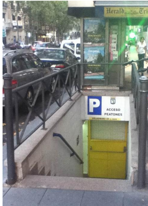
Adaptación de estacionamientos subterráneos.
