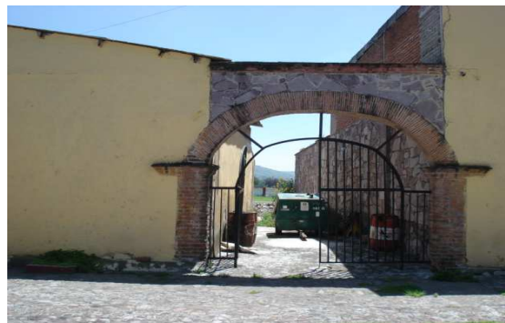
Fig. 29 En esta fotografía se puede ver uno de los accesos principales desembocando en un patio interior de la ex-Hacienda
