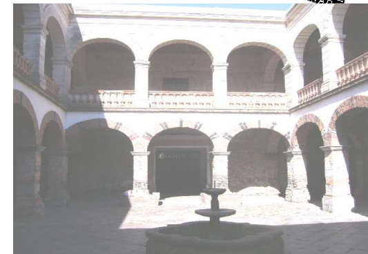
Fig. 21 Se aprecia el atrio interior de la casa del hacendado, en la hacienda de San Antonio
