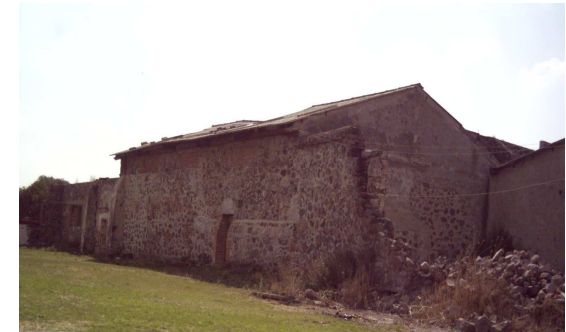
Fig. 28 Aquí se muestra la intervención en la cubiertaza, la ventilación e iluminación son a base de grandes ventanas, los muros de piedra tienen espesor de 0.60 cm
