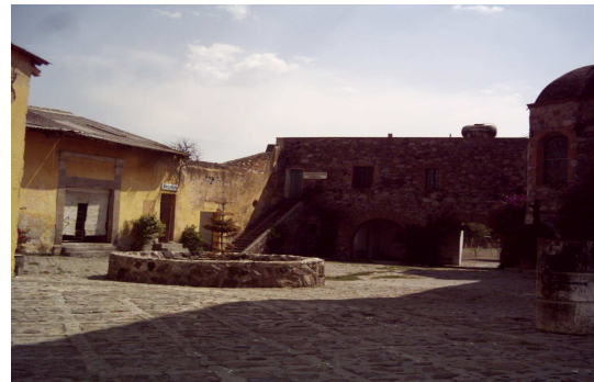
Fig. 27 Vemos la fachada posterior de trojes y al fondo la casa de los padres que en la actualidad, son las oficinas administrativas de la ex-Hacienda
