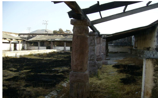
Fig. 32 Estado actual de la fachada sur de las caballerizas
