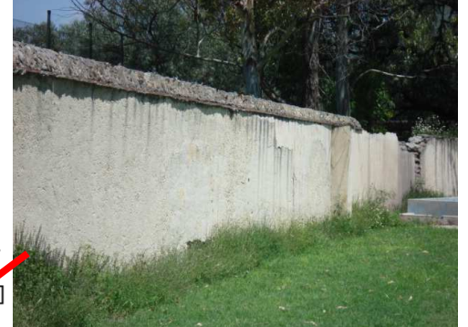
Fig. 39 Otro muro de la fachada sur, en buen estado de conservación
