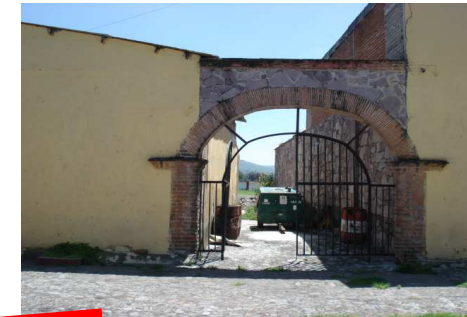
Fig. 42 Acceso a las caballerizas
