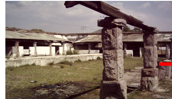
Fig. 50 Acceso a las caballerizas
