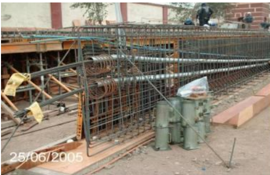
CIMBRA 1ra CARA Y DUCTOS DE POSTENSADO
