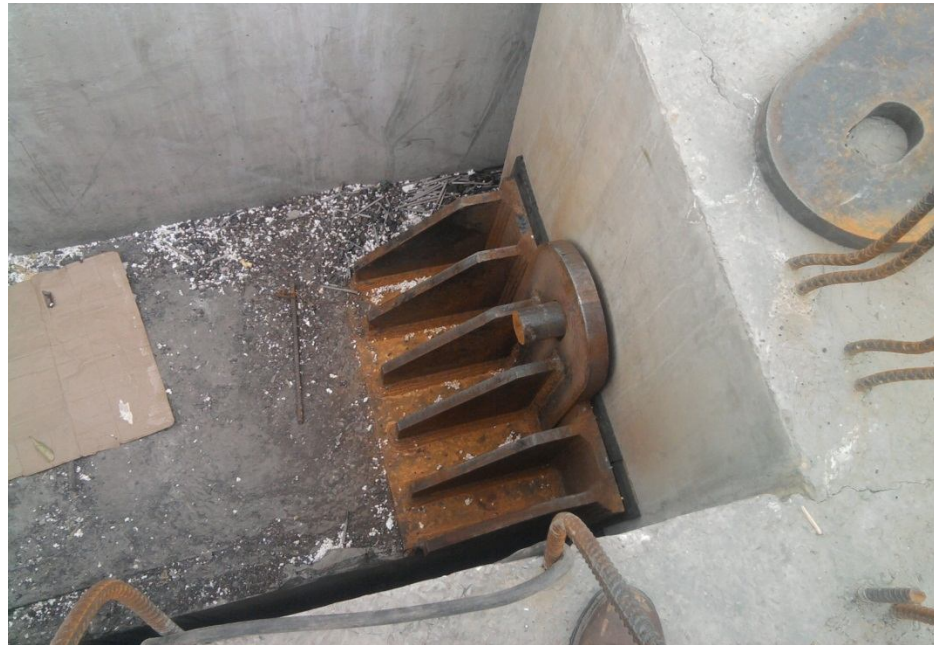
Colocación de placas y atezadores en las conexiones con las trabes
