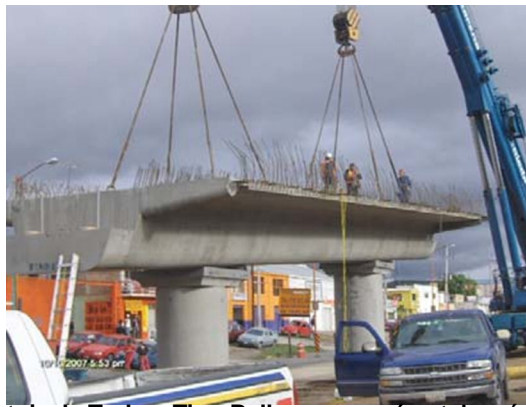
Montaje de Traves Tipo Ballena con grúas telescópicas
