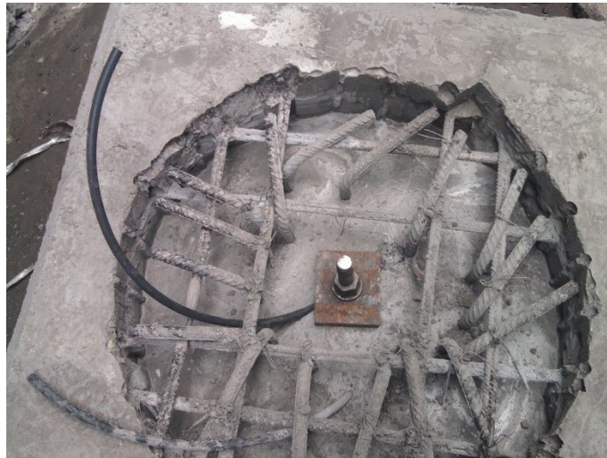
Placa tuerca y manguera de inyección
