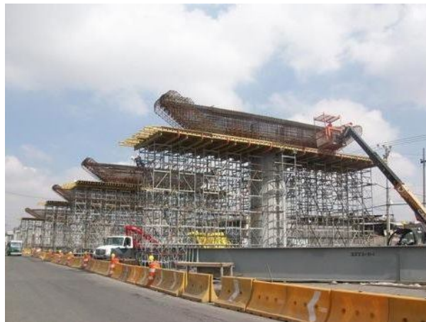
ARMADO DE TRABE VIADUCTO ELEVADO LINEA 12
