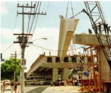
CABLES ELÉCTRICOS CERCANOS
