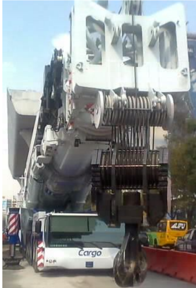
Grúa telescópica utilizada en el montaje del viaducto elevado
