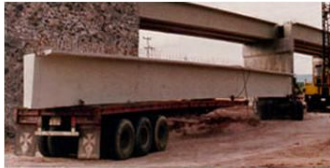
TRACTO CON SEMIRREMOLQUE UNIDO A LA TRABE
