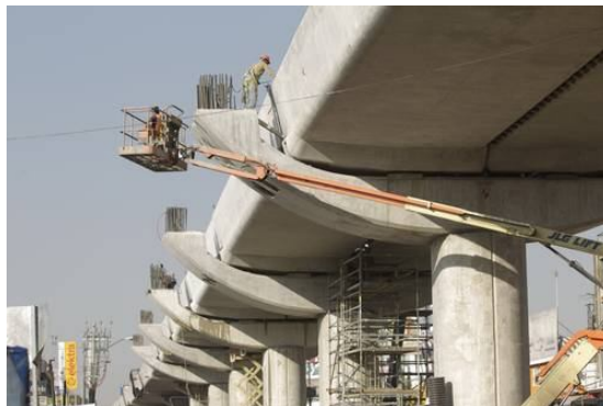
Viaducto elevado línea 12 del metro
