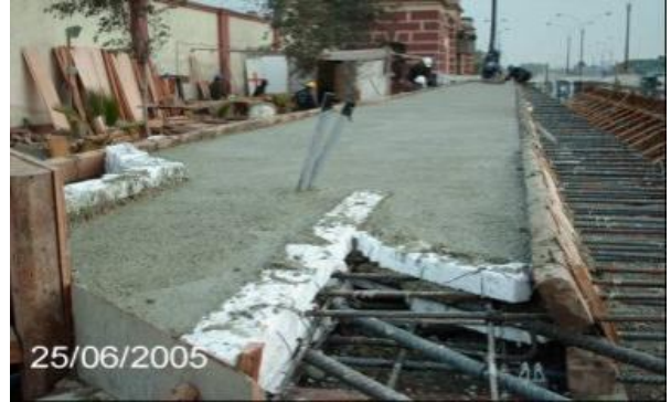
VACIADO TERMINADO CON DUCTOS PARA INYECCIÓN
