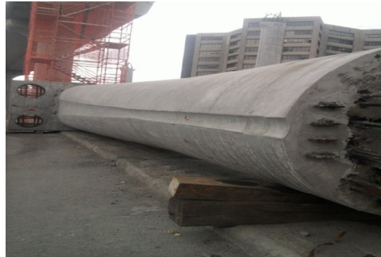
Columna prefabricada acabado final
