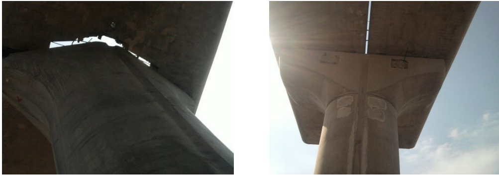
Conexión de trabe columna prefabricada
