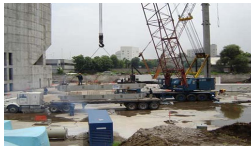
Montaje con Grúas Estructurales.
