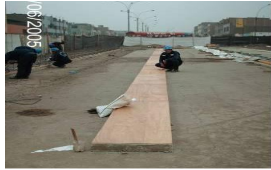
ENCOFRADO DE FONDO DE VIGA
