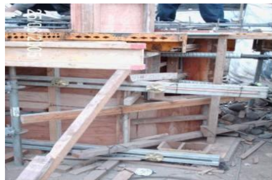
CIMBRA EN ALEROS DE LA TRABE
