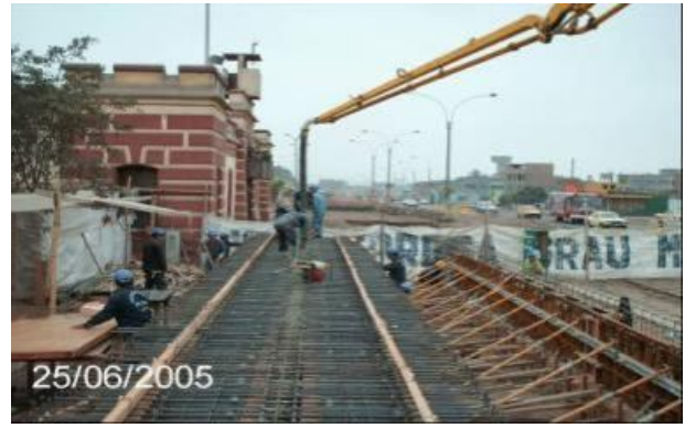
VACIADO DE CONCRETO
