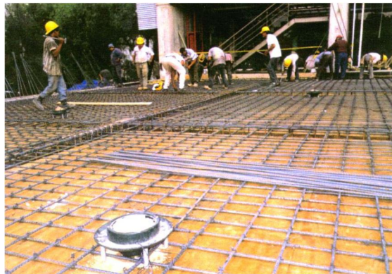
Losa maciza en proceso de construcción
