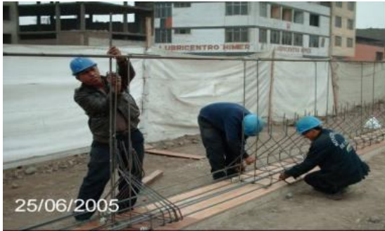
COLOCACIÓN DE ACERO DE REFUERZO
