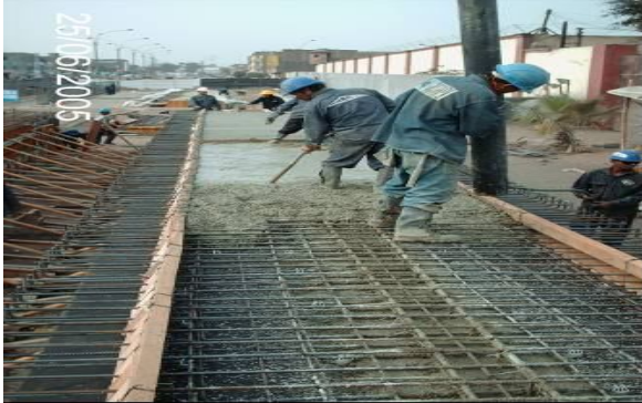
VACIADO Y VIBRACIÓN DEL CONCRETO
