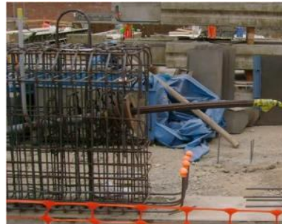
Acero de Refuerzo
