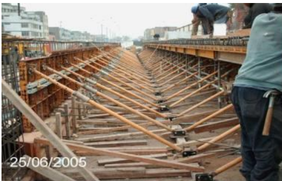
APUNTALAMIENTO DE LA CIMBRA
