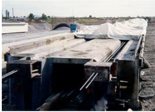
Vista de elementos curados a vapor
