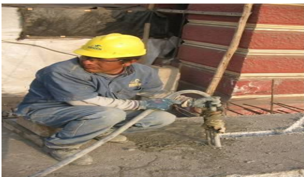
RELLENO DE MORTERO LÍQUIDO
