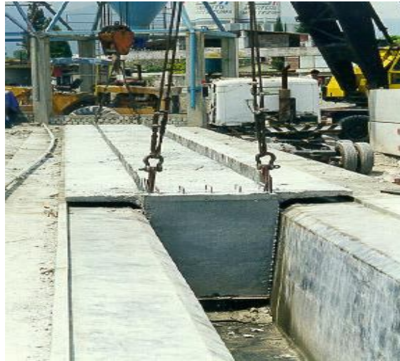
Desmolde de trabe cajón
