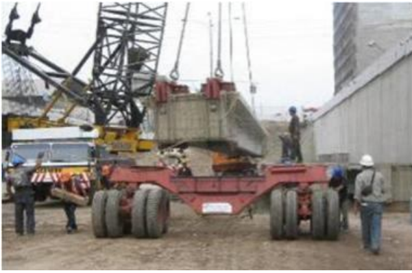
TRANSPORTE DE VIGA CON TRACTO Y PATÍN TRASERO
