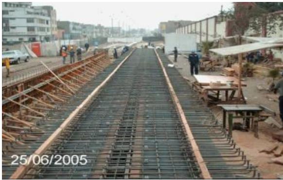
COLOCACIÓN DE ACERO SUPERIOR
