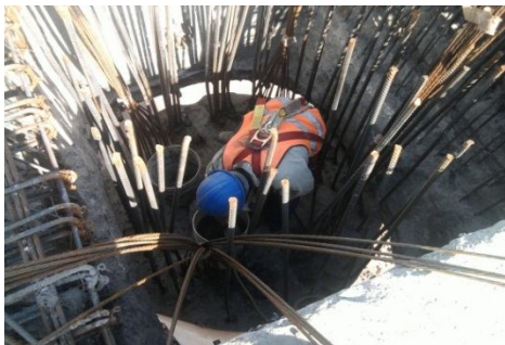
Travesaño columna en su conexión
