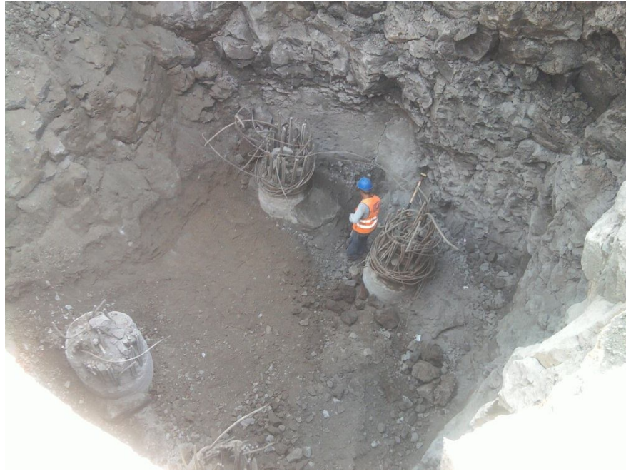
Pilas de cimentación
