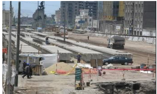
ALMACENAJE DE VIGAS
