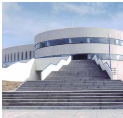
Edificio ejecutado con prefabricados de concreto presforzado.
