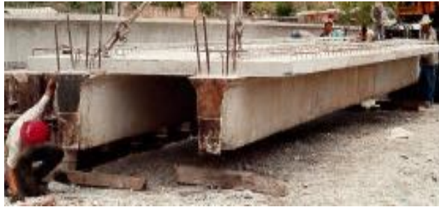
Apoyos en almacenaje de trabes doble T
