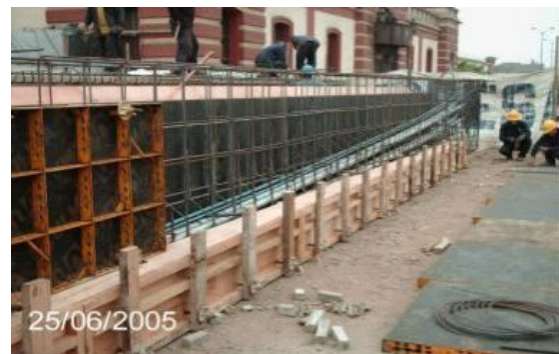
COLOCACIÓN DE CIMBRA 2da CARA
