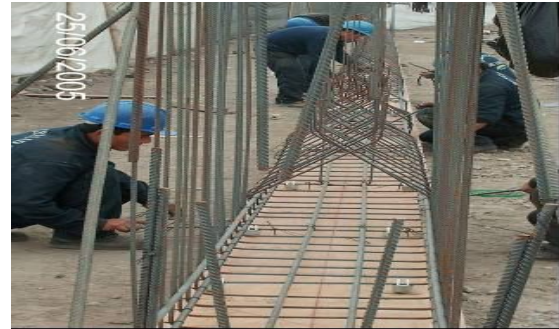
COLOCACIÓN DE ACERO DE REFUERZO
