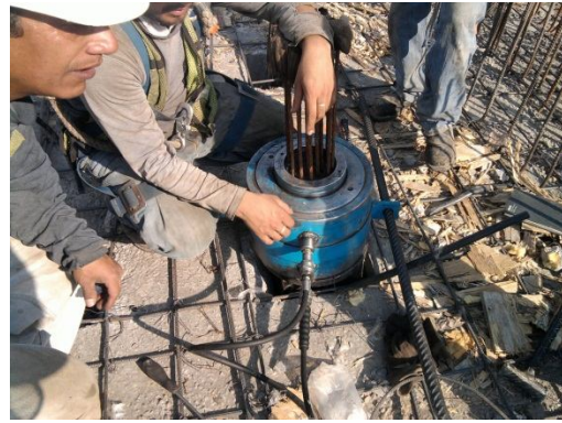
Proceso de tensado con gato hidráulico
