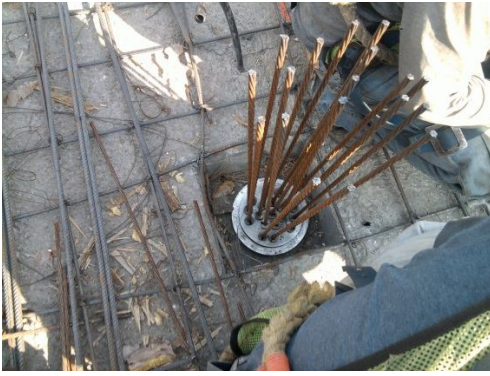
Placa y cuñas para tensado
