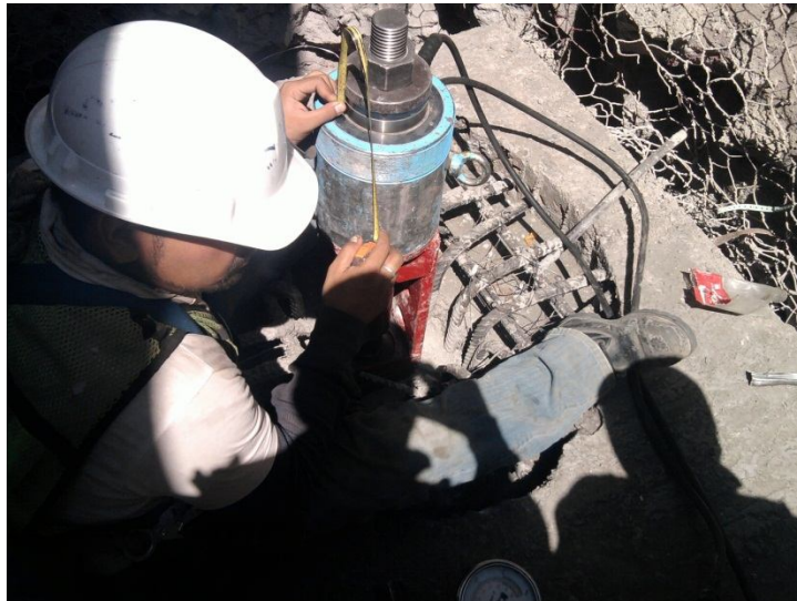
Tensado de anclajes en pila zapata
