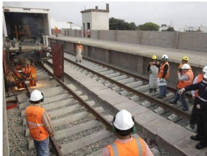
Colocación de durmientes con rielera
