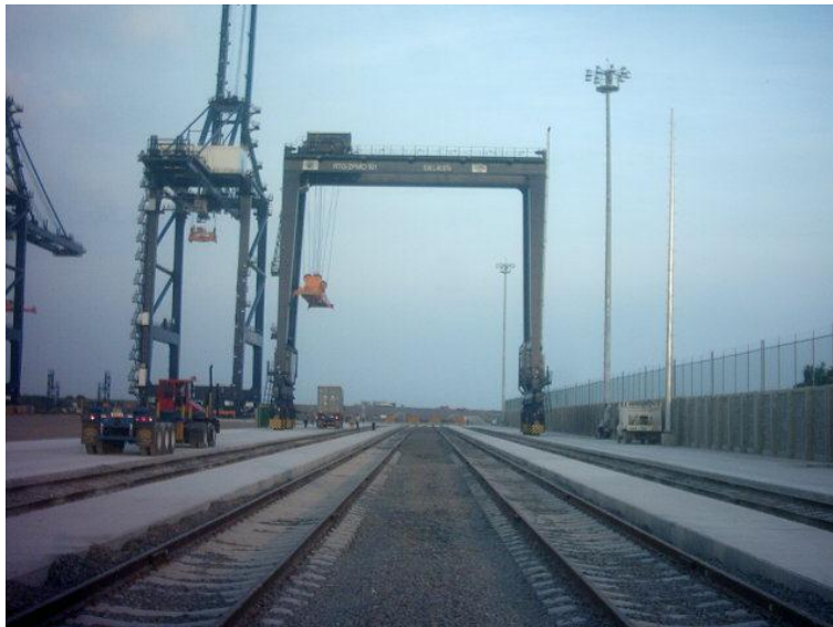
Figura 6. Grúa RTG en vías de ferrocarril
