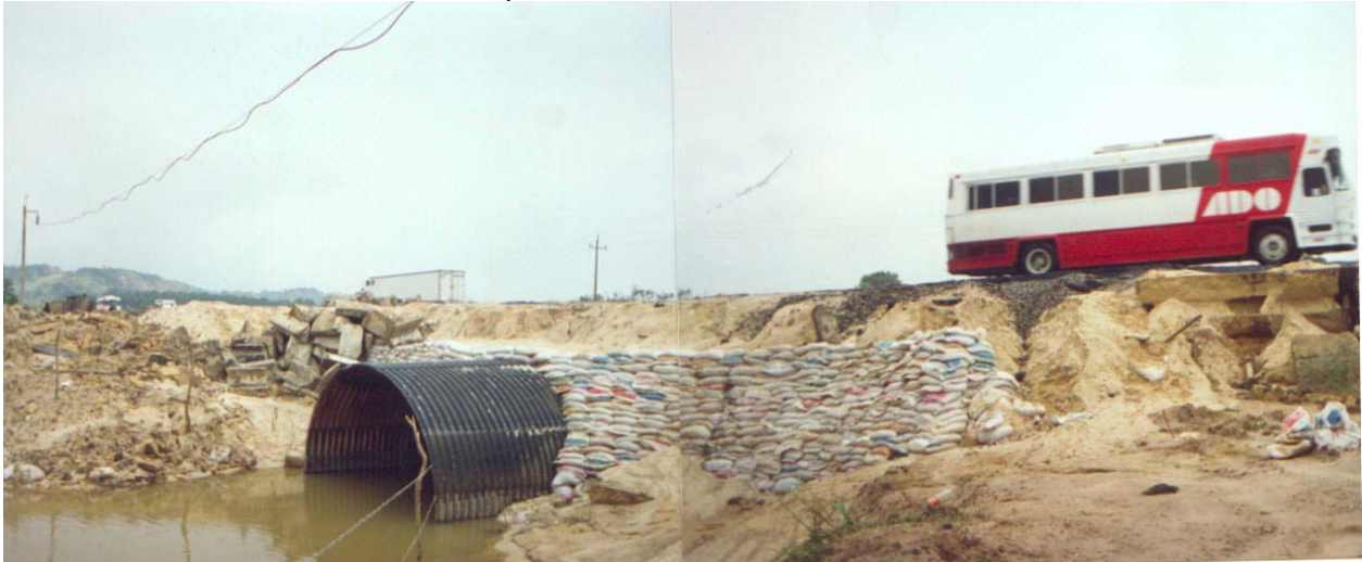
Figura 1.5 Cruce del arroyo Agua Dulce con la carretera federal 180
