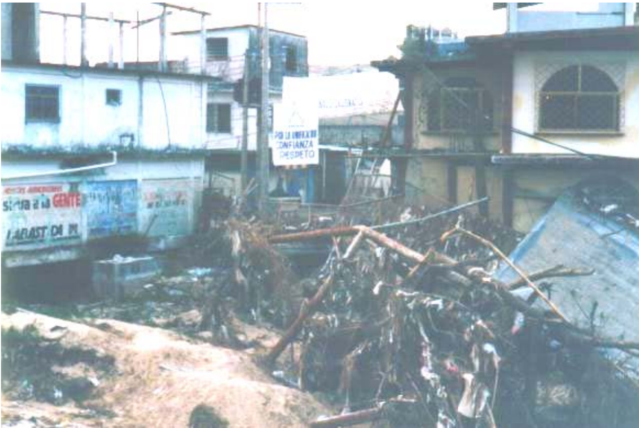
Figura 3.15 Puente destruido. Obstrucciones en los estribos del puente
