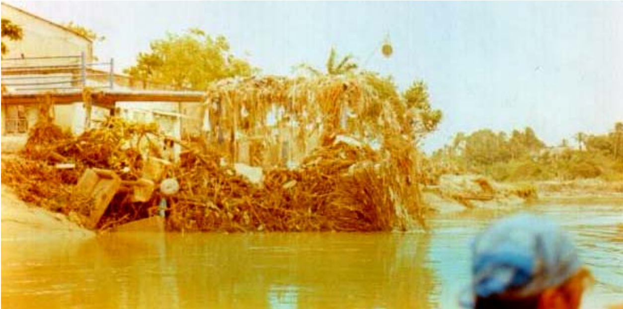
Figura 3.14 Puente destruido. Obstrucciones en los estribos del puente
