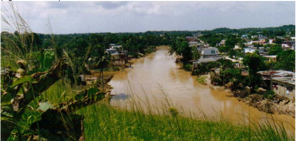
Figura 3.7 Vista del cauce del arroyo Agua Dulce, tramo aguas abajo, obstrucciones en ambas márgenes
