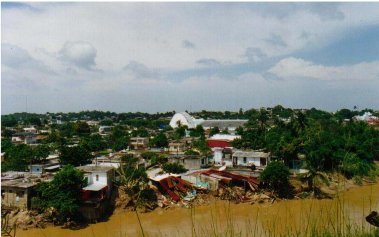
Figura 3.9 Vista del arroyo Agua Dulce, aguas abajo, obstrucciones en margen izquierda
