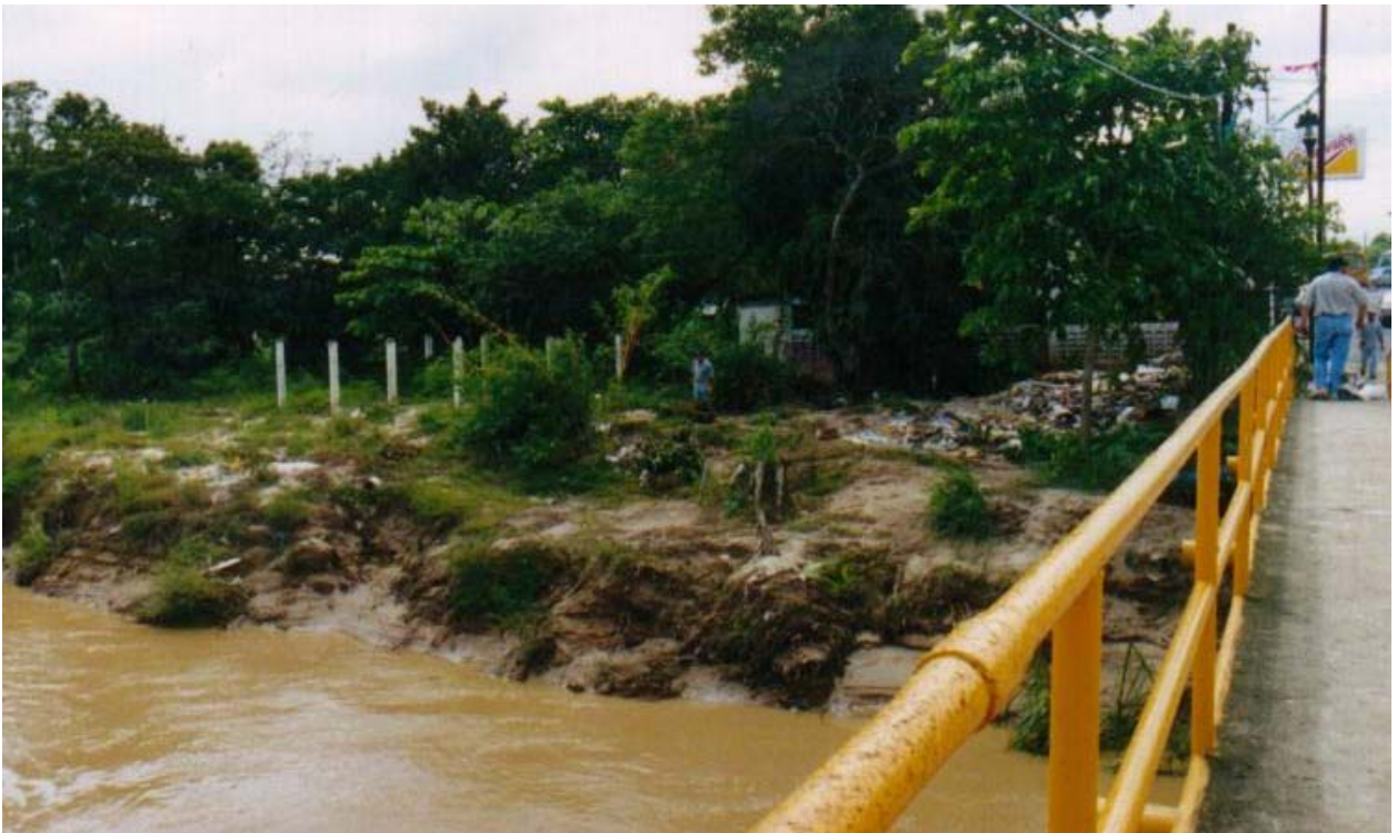
Figura 3.3 Vista de la constitución de material del cauce del arroyo Agua Dulce, tramo aguas arriba
