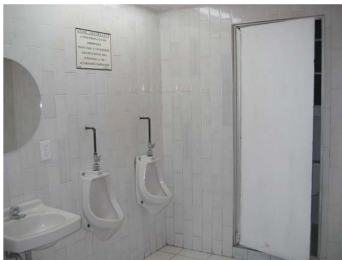
Sanitarios del entrepiso recubiertos de azulejo
