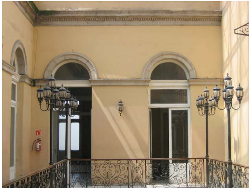
Fotografía época actual tomada por el autor el 8 de agosto de 2008. En esta fotografía se puede apreciar que desapareció la cubierta sobre los corredores y el vitral emplomado que se encuentra a la izquierda de la fotografía de archivo. Las lámparas son agregados al edificio.
