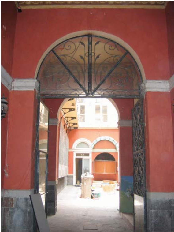
Recibidor de acceso principal (Zagúan). El portón trabajado en acero forjado se someterá a limpieza y eliminación de restos de pintura y óxido. Vista desde el acceso (izq) vista desde el patio central (der)
