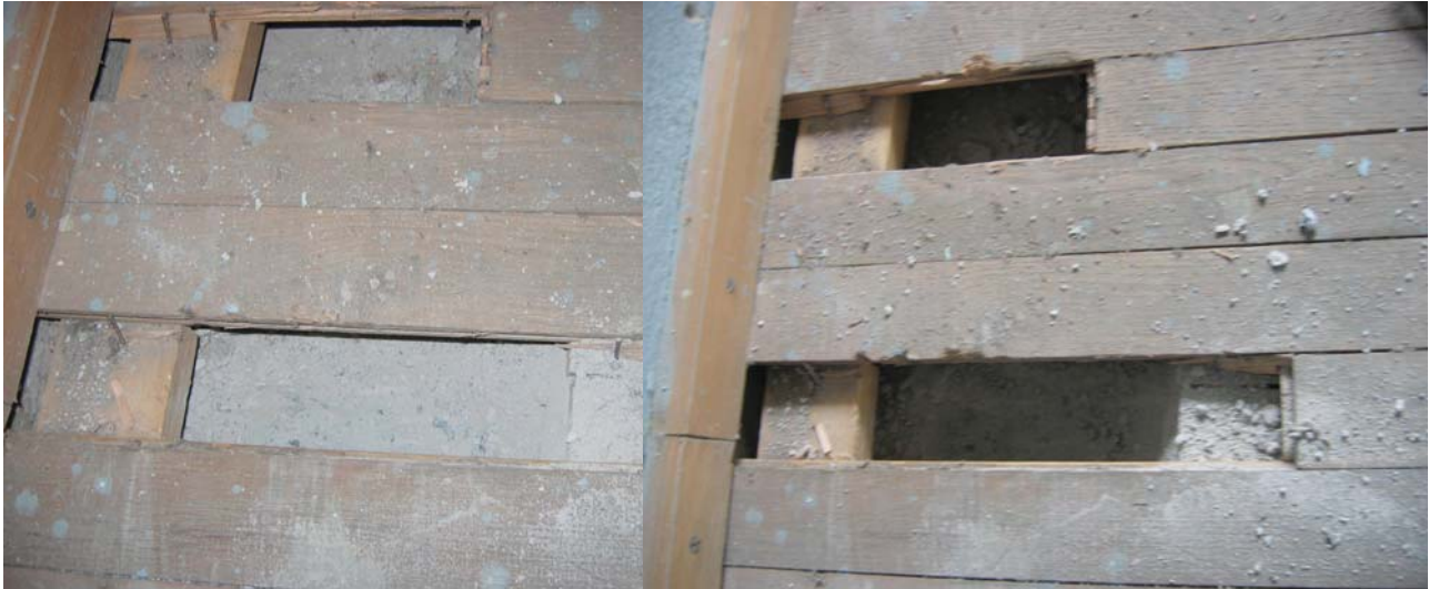
Secuencia de fotografías de las calas realizadas en el entrepiso del tercer nivel
