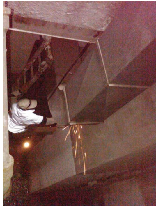
Desmantelamiento de ductos de extracción de lámina galvanizada. Demolición de ducto de elevador de carga y servicios
