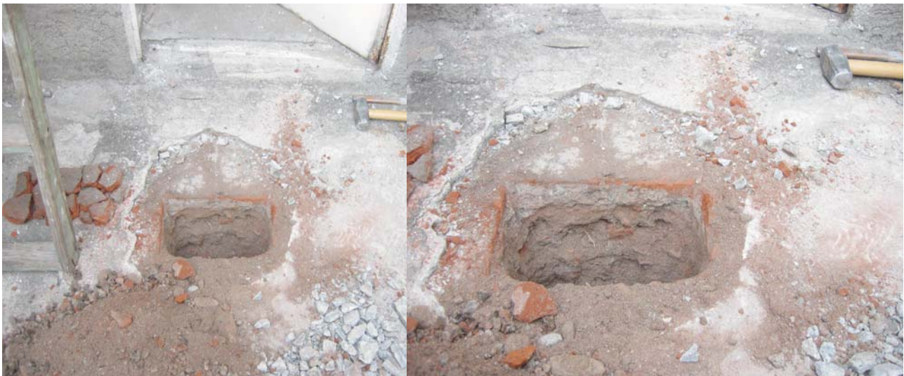
Detalle y secuencia de fotografías de entrepiso de la azotehuela en el cubo de la parte posterior del edificio. Sistema constructivo tradicional a base de lámina acanalada de acero sobre viguetas metálicas, relleno de tezontle o tierra, y capa de compresión de concreto como acabado final.
