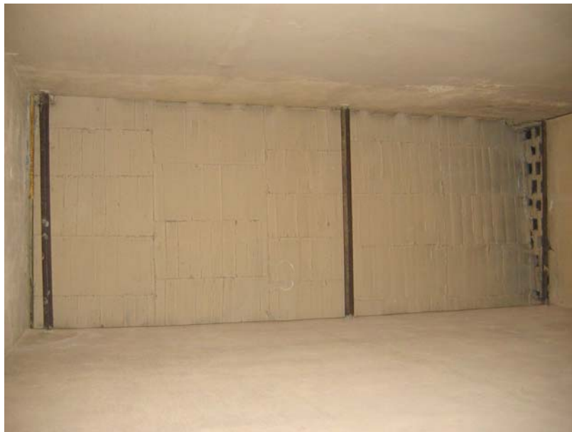
Losa tapa de la escalera de servicio fabricada en concreto armado.
