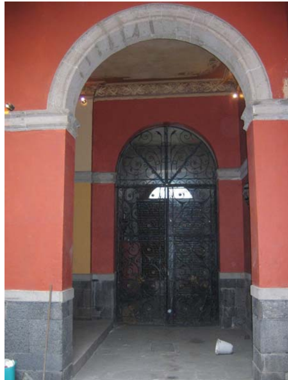
Recibidor de acceso principal (Zagúan). El portón trabajado en acero forjado se someterá a limpieza y eliminación de restos de pintura y óxido. Vista desde el acceso (izq) vista desde el patio central (der)
