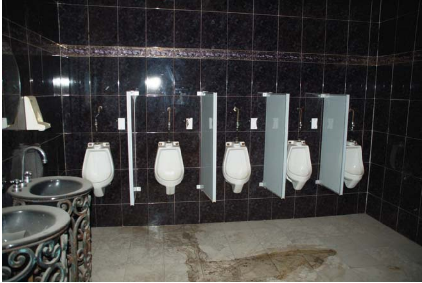
Retiro de lambrines de azulejo, mamparas, mingitorios, lavabos, accesorios de baño, pisos de azulejo, plafones de yeso sobre metal desplegado. Vista general de acabados en baños.
