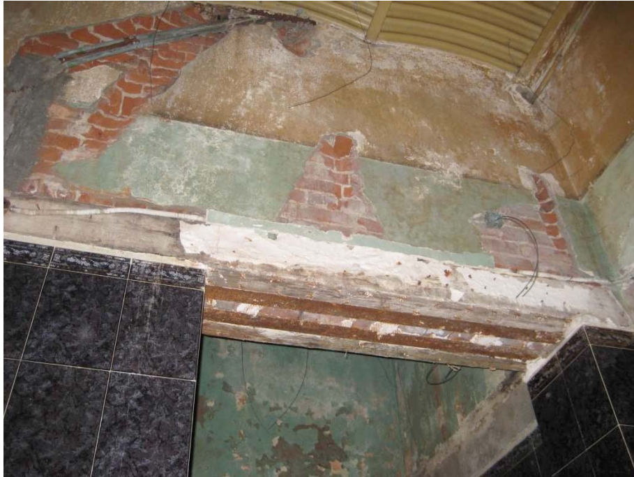
Detalle de las calas realizadas en marcos de muros en baños de la planta baja. Se puede observar los dinteles reforzados con vigas de madera y metálicas.
