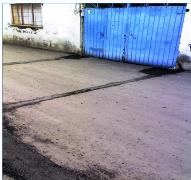
Ilustración 18 BACHEO DE ZANJAS EN GALEANA.
