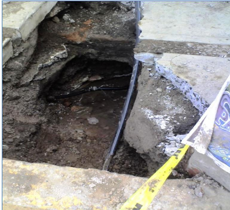
Ilustración 16 EXCAVACIONES PARA UBICAR LAS TOMAS.
