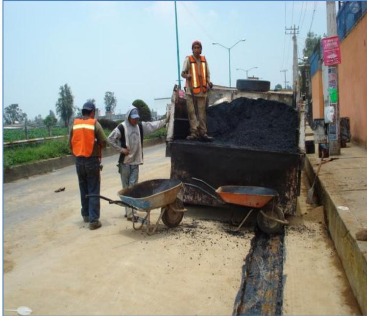
Ilustración 19 ACARREO DE CONCRETO ASFÁLTICO EN DIFERENTES FRENTER.
