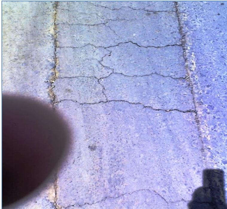
Ilustración 32 SE MUESTRAN AGRIETAMIENTOS EN LA ZONA DE HIDALGO, POR MALA COMPACTACIÓN.
