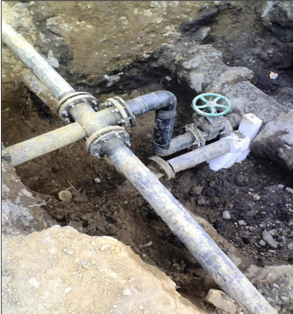
**Ilustración 14** Construcción de caja de válvulas en el tramo Tláhuac-Obra ejecutada por la Delegación Tláhuac.
