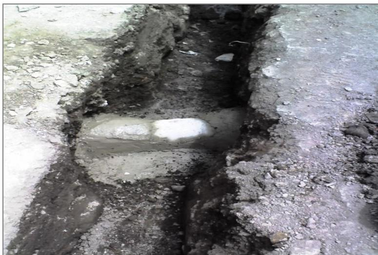
**Ilustración 43 REPARACIÓN DE ALBAÑAL EN AV.TLÁHUAC.**
