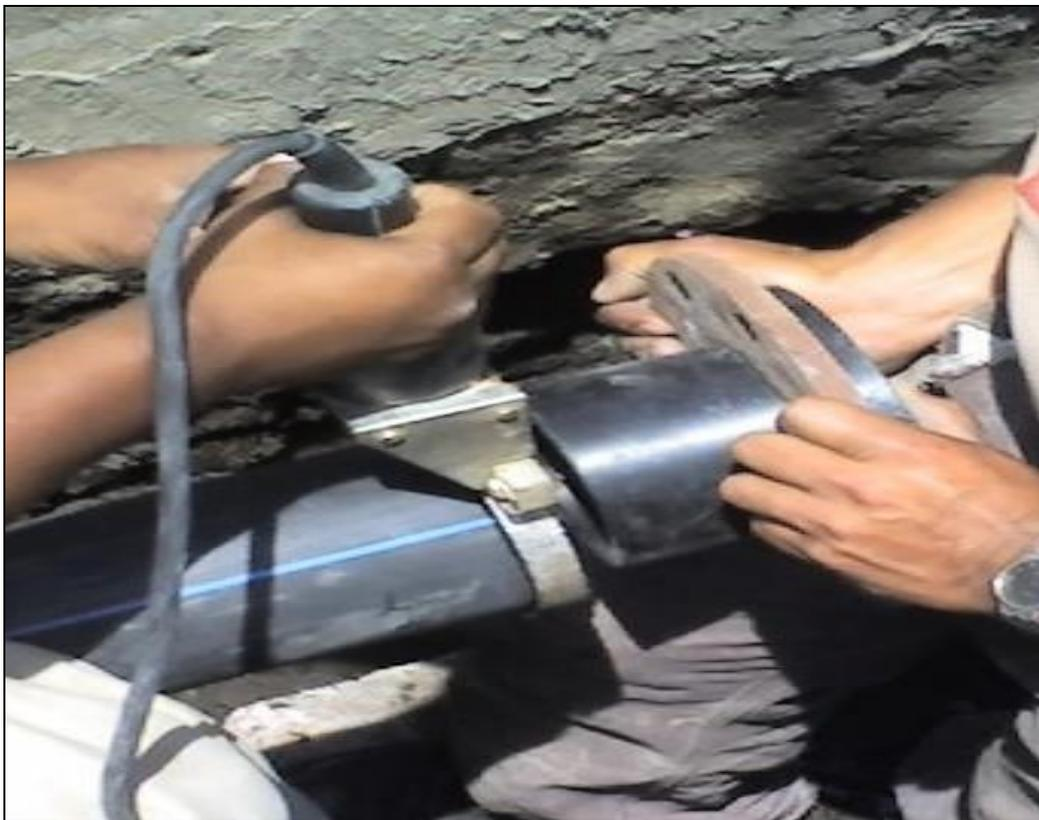
Ilustración 12 Termofusión de la brida y contra brida.
