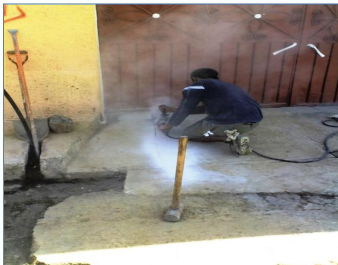
Ilustración 14 CORTE CON SIERRA DE VENTANAS.
