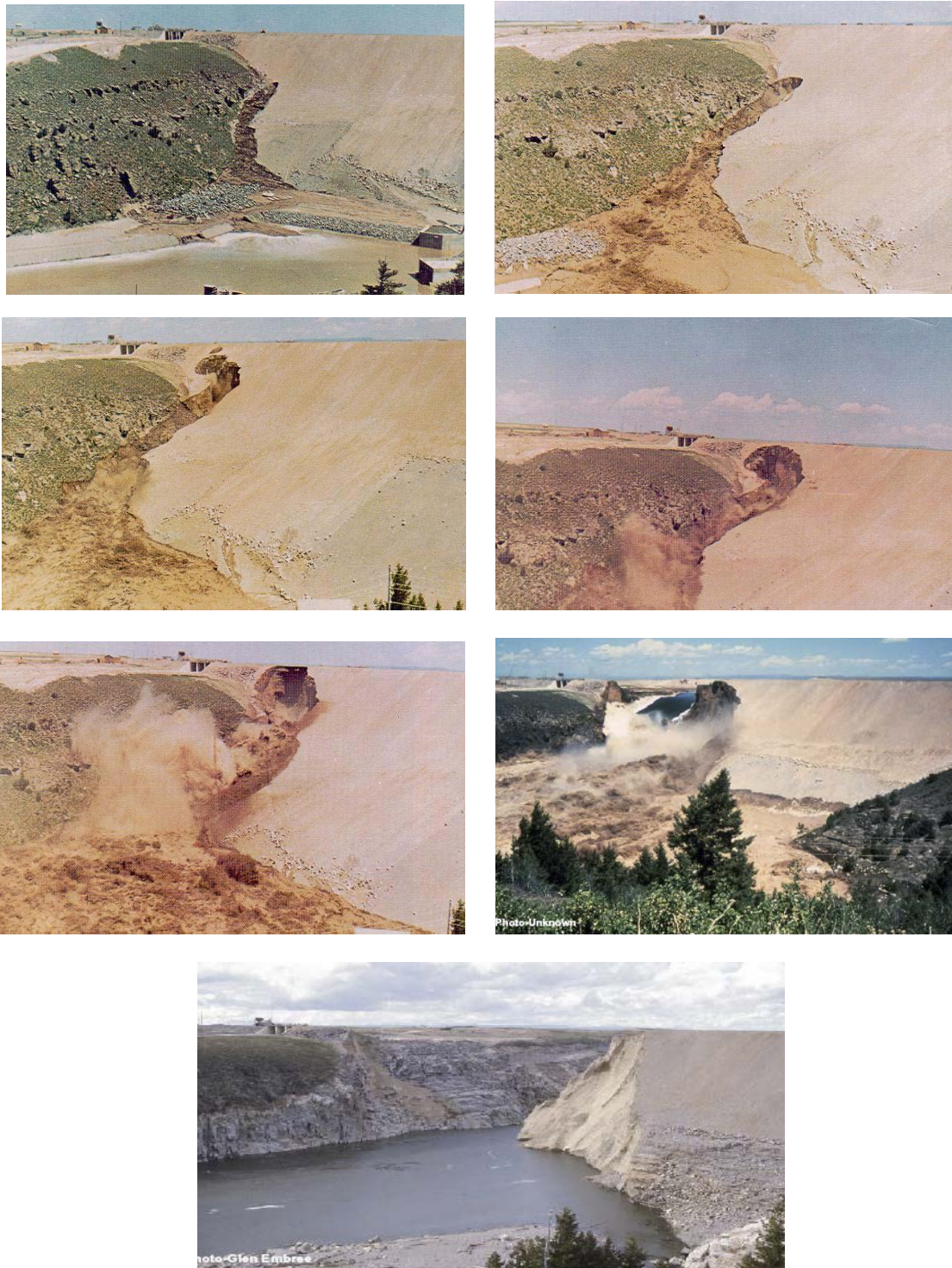
Fig. 4.11 Secuencia de falla por erosión interna en la Presa Teton, Estados Unidos (imagen tomada de internet).
