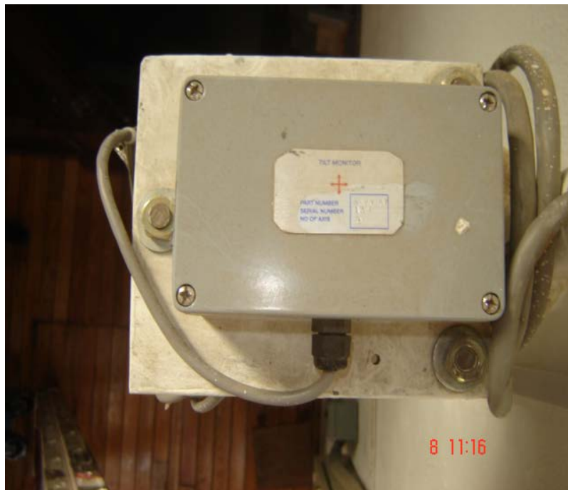
Fig.5.5 Inclinómetros instalados en diversas secciones del Palacio Nacional.
