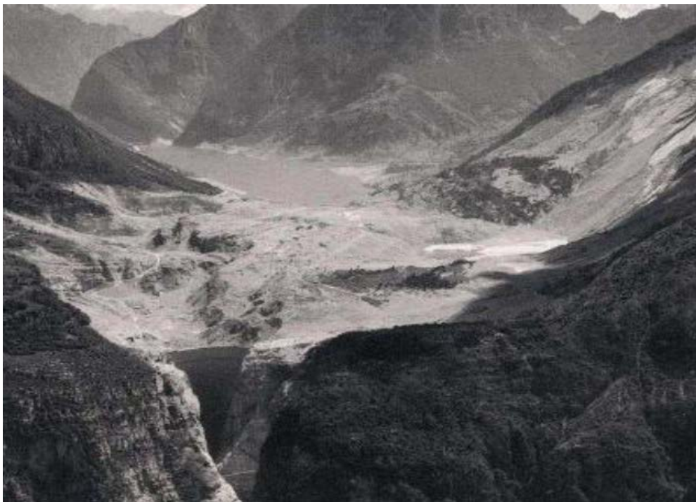
Fig.4.13 Pérdida del bordo libre de la presa Vajont, Italia, debido al deslizamiento de laderas (imagen tomada de internet).
