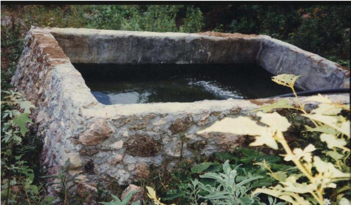
**Figura 8. Terminación de una caja de captación de agua dulce.**
