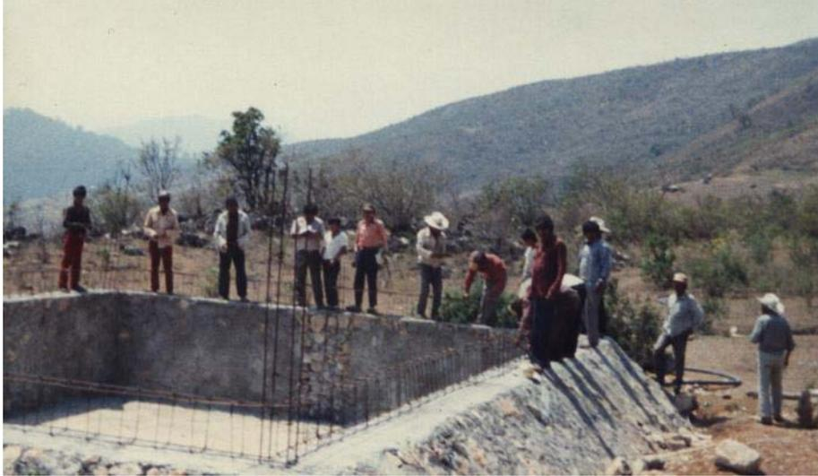
**Figura 23. Trabajando en la construcción de una obra de almacenamiento de agua para riego, en la comunidad de la Sabana Copala.**
