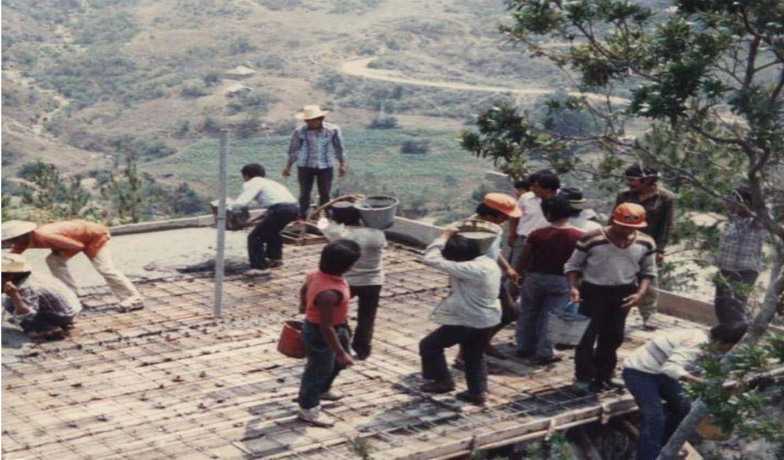
Figura 17. Todos ayudan al albañil de Chicahuaxtla, quien terminó la construcción del tanque de agua en San Juan Copala.
