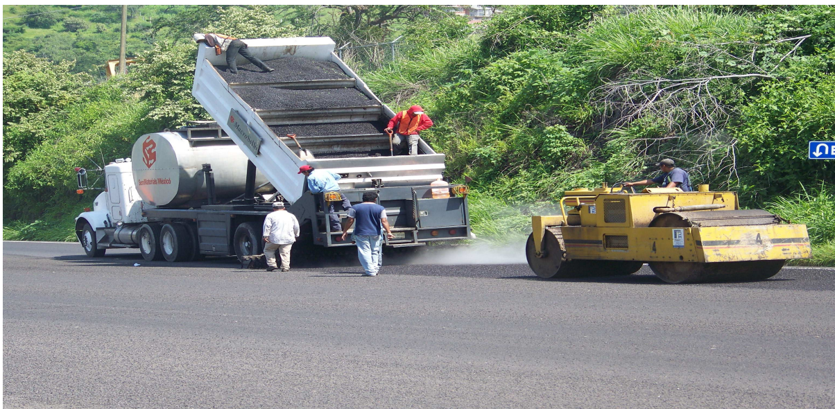
Foto No. 13 a) Riego de sello, del tipo sincronizado.
