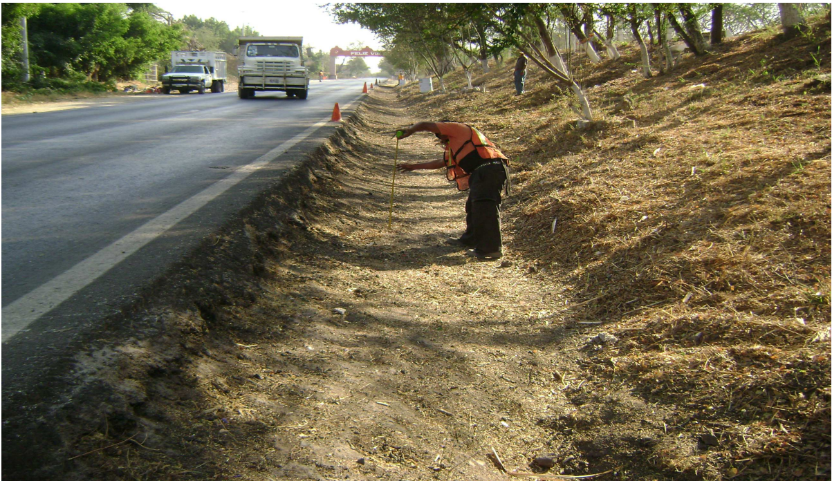
Foto No. 11 a) Trabajos de construcción de cunetas con concreto hidráulico
