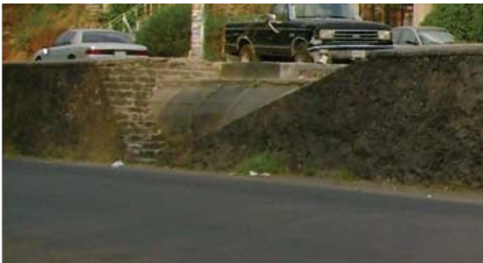
Imagen 45. Fotografía de las escaleras en el acueducto
